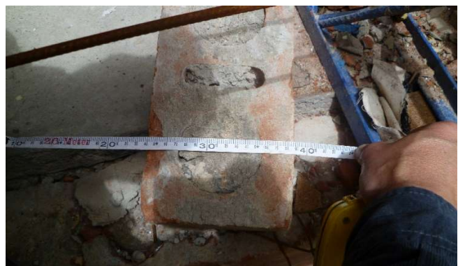
Foto N. 35. Revisión de elementos afectados,
