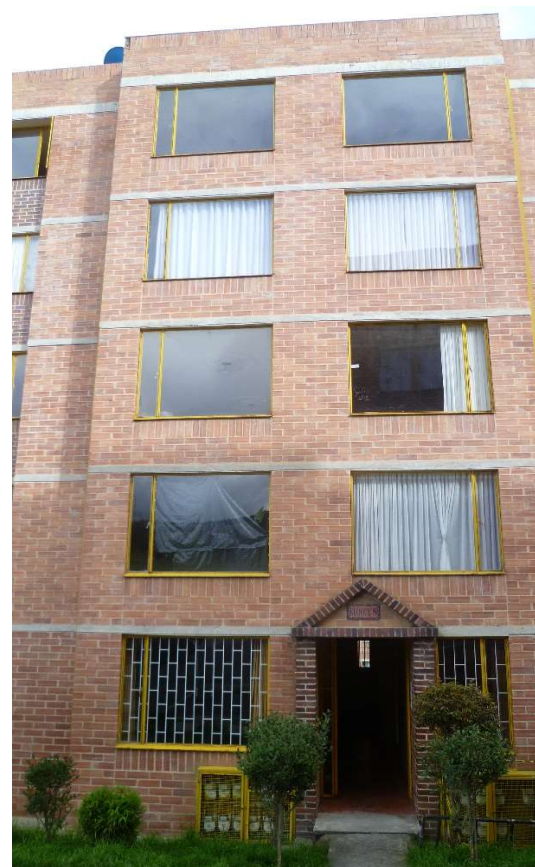
Foto N. 4. Acceso del Edificio en Estudio.
