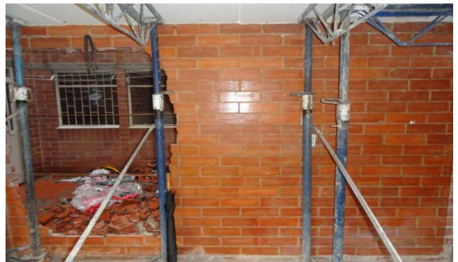
Foto N. 14. Apuntalamiento de área afectada.
