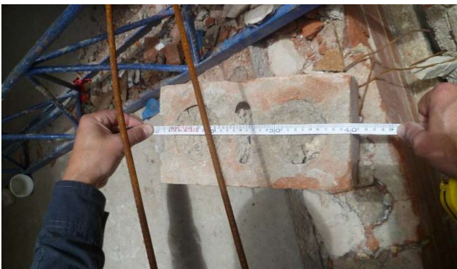
Foto N. 36. Revisión de elementos afectados,
