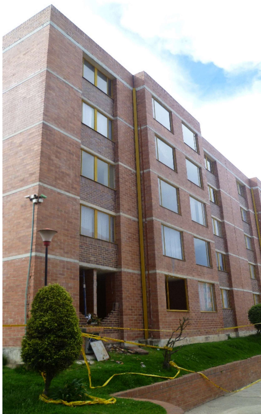
Foto N. 3. Vista bloque 8 costado oriental.
