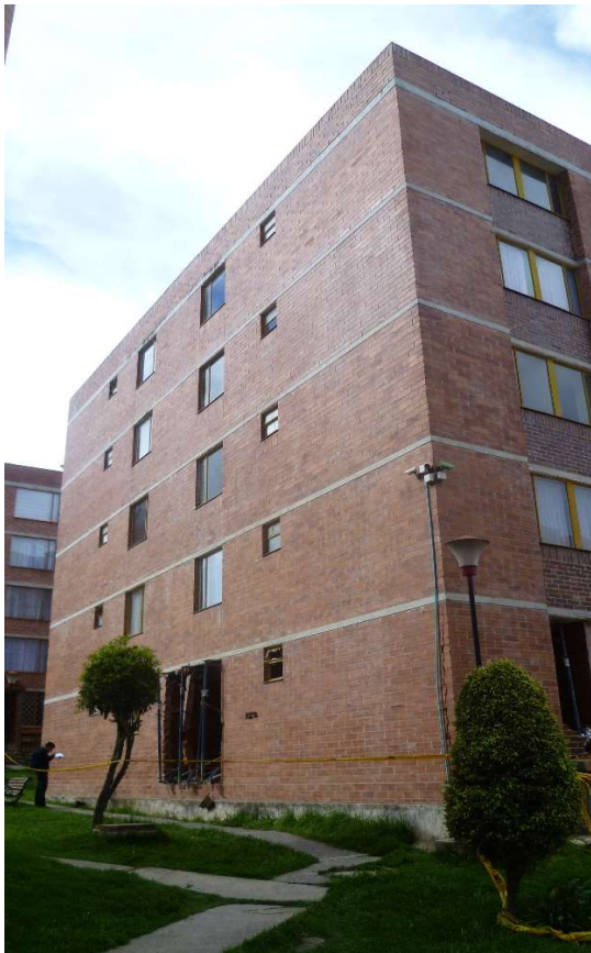
Foto N. 5. Vista Bloque 8 costado sur.
