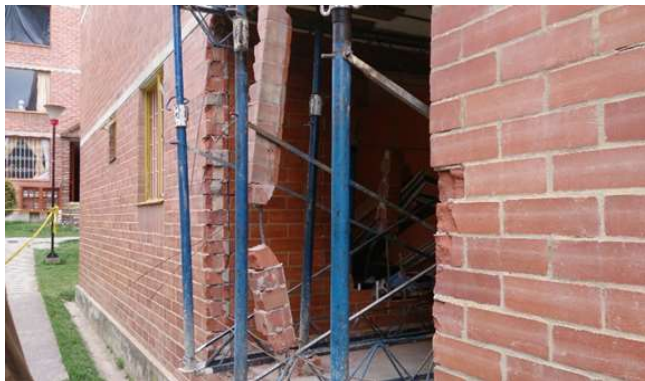
Foto 11. Apuntalamiento temporal zona afectada.
