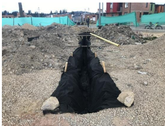
Fotografía 4 Instalación de Geotextil para la construcción de filtro francés
