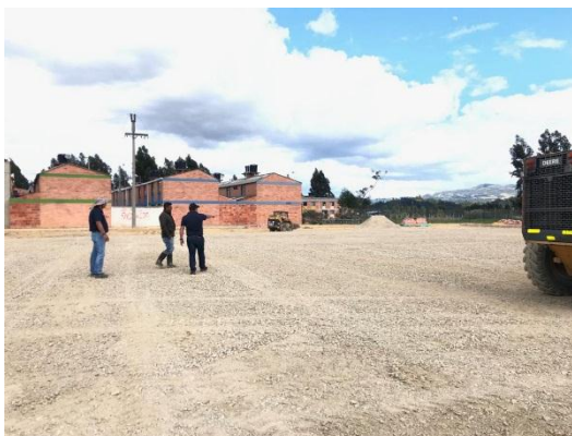
Fotografía 9 Visita técnica al instalar capa de base granular BG-38
