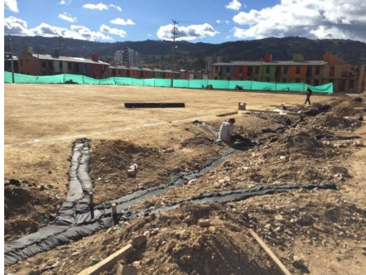
Fotografía 7 Filtro perimetral canchas costado Norte
