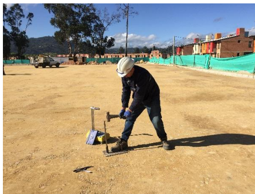
Fotografía 10 Toma de densidades Sub-base granular (SBG-50)
