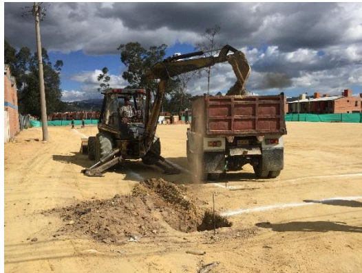
Fotografía 3 Excavación mecánica para obras de drenaje en zona de canchas
