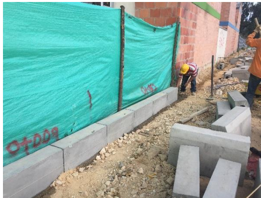
Fotografía 1 Instalación de sardinel
