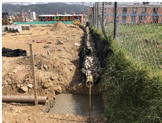
Fotografía 6 Colocación de balastro \frac{3}{4} "al sistema de drenaje
