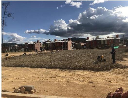
Fotografía 2 Construcción capa de base granular BG-38 en canchas
