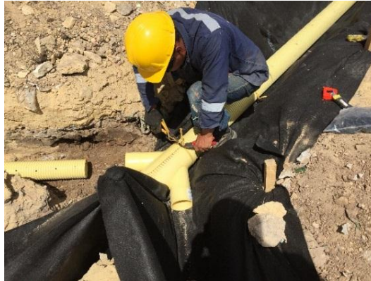
Fotografía 5 Instalación de tubería en filtro francés
