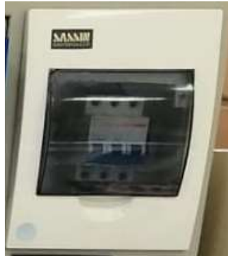
Figura 74. Caja Breaker termo magnético
