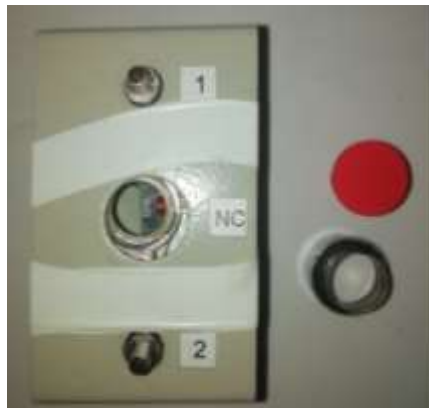
Figura 43. Estado antiguo de los elementos de sujeción.
