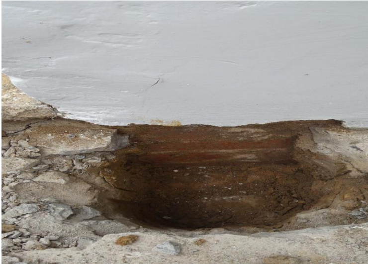
Figura No. 30 Apique De Cimentación 1
