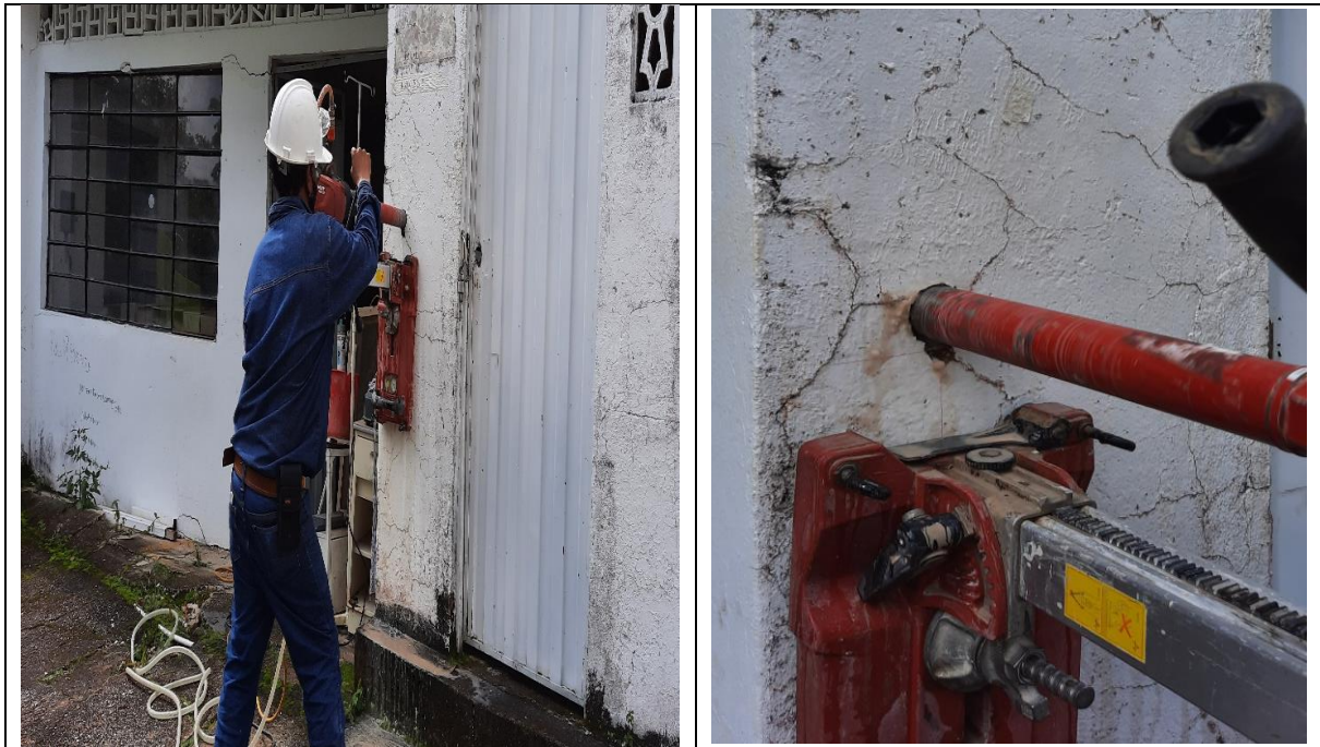
Figura No. 37 Extracción Núcleo No. 4 – Zona de Ropas Columna
