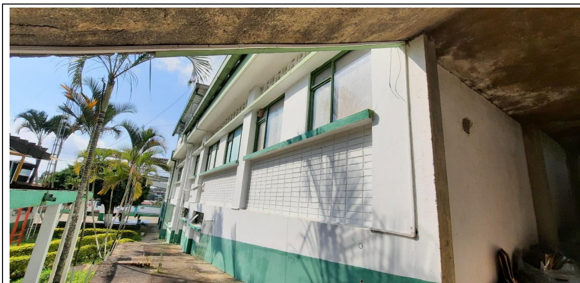
Figura No. 4 Vista Fachada Sur. Fuente: Propia
