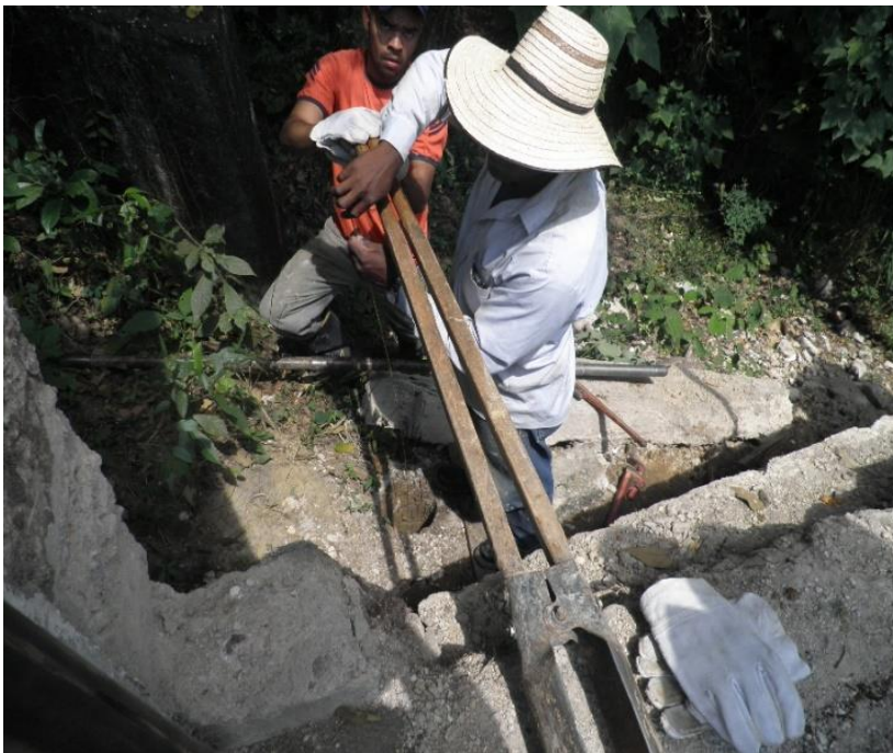
Figura No. 31 Apique De Cimentación 2
