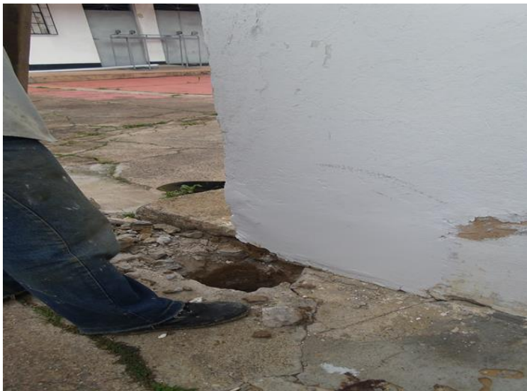
Figura No. 29 Demolición Placa De Contrapiso – Apique De Cimentación 1
