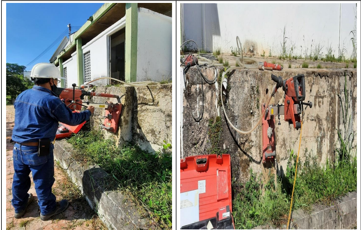
Figura No. 36 Extracción Núcleo No. 3 – Muro de Contención
