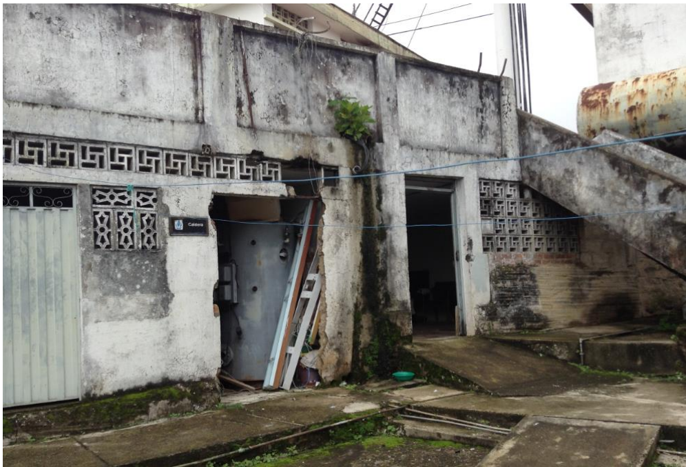
Figura No. 11 Estado Actual de la Edificación Fuente: Propia.
