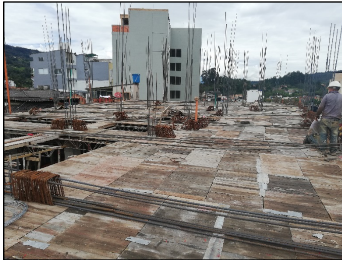
Imagen 17 Armado casetones Nivel 2
