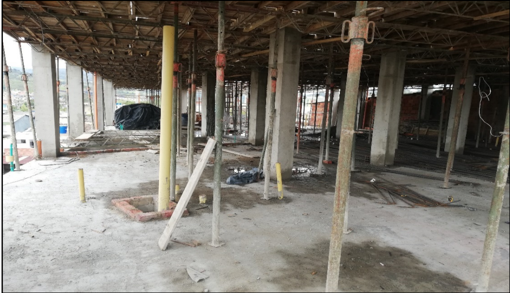
Imagen 19 Visualización columnas y formaletas
