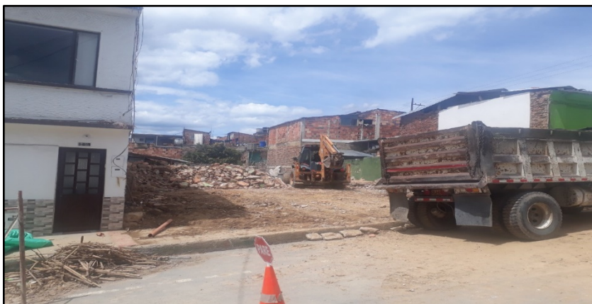
Imagen 4. Demolición de obra
