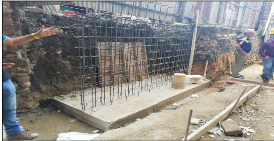
Imagen 15. Muro en obra
