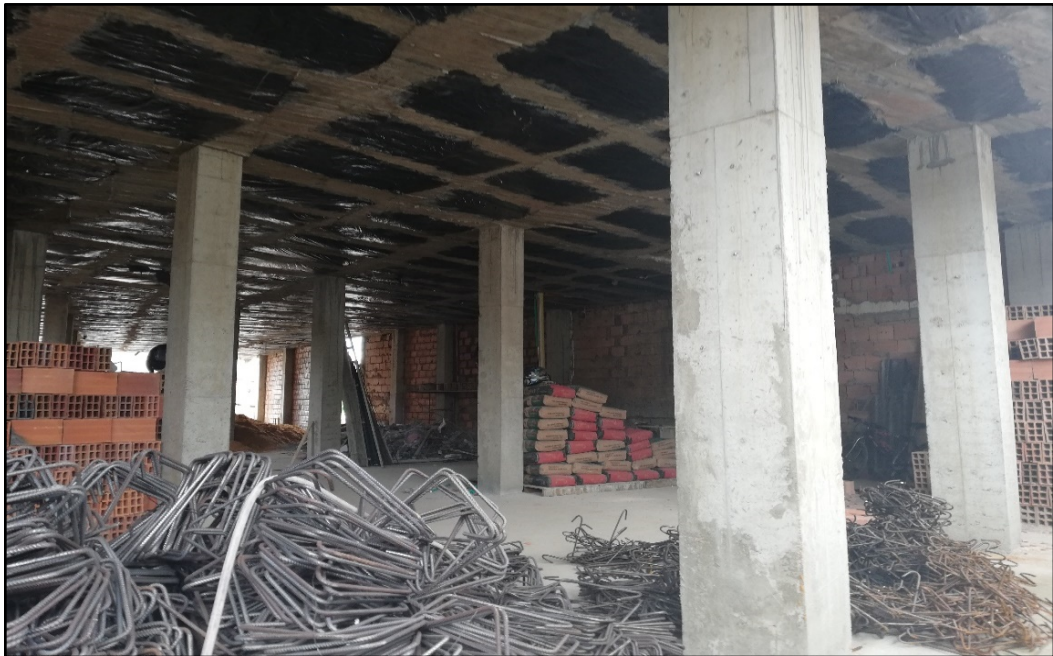
Imagen 20 Visualización columnas y formaletas
