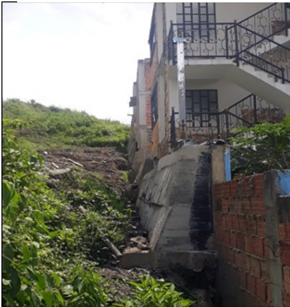
Imagen 3. Muro de contención
