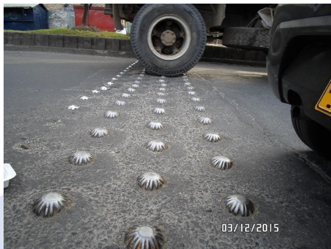
Imagen 11. Pulimento de agregados en mezcla asfáltica usada para fijación de reductores de velocidad. Fuente: Este trabajo
