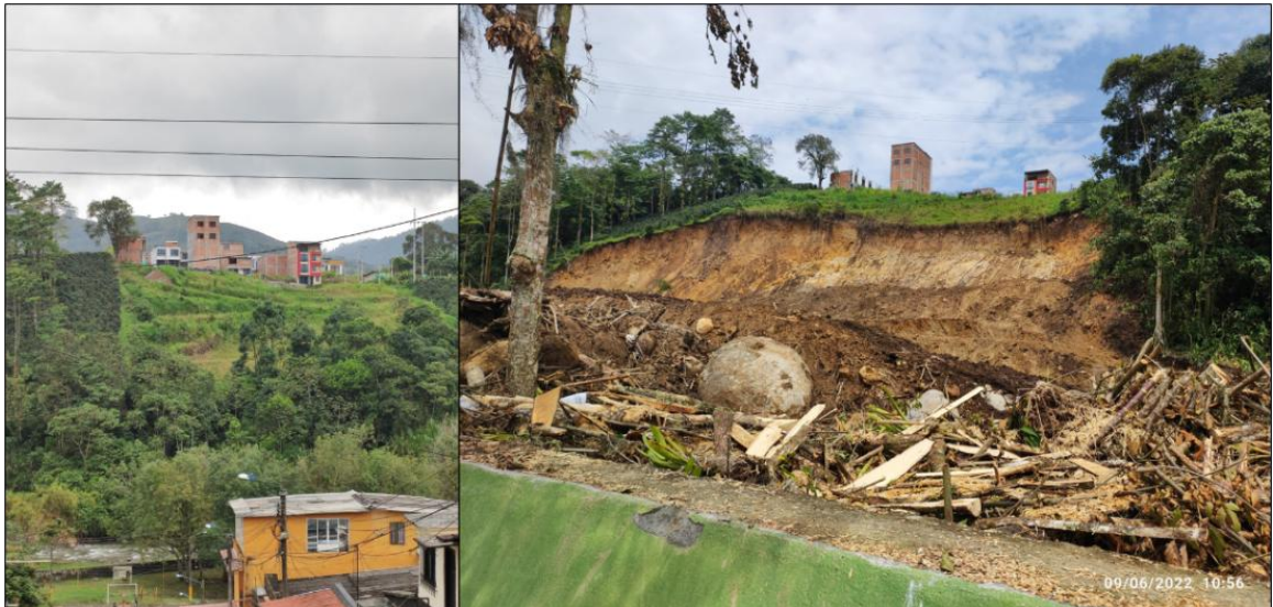
Figura 7. Evidencias fotográficas de uso inadecuado del suelo en la vertiente izquierda del río San Eugenio. A) Toma de la vertiente occidental del barrio La Trinidad previo al movimiento en masa. B) Evidencia de movimiento en masa detonado por sobreexplotación del uso del suelo y precipitaciones pico.
