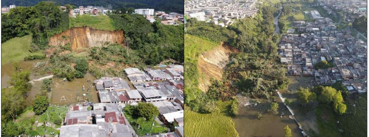
Figura 6. Evidencia fotográfica de evento torrencial ocurrido el 25 de mayo de 2022 en el barrio La Trinidad, cabecera municipal de Santa Rosa de Cabal.
