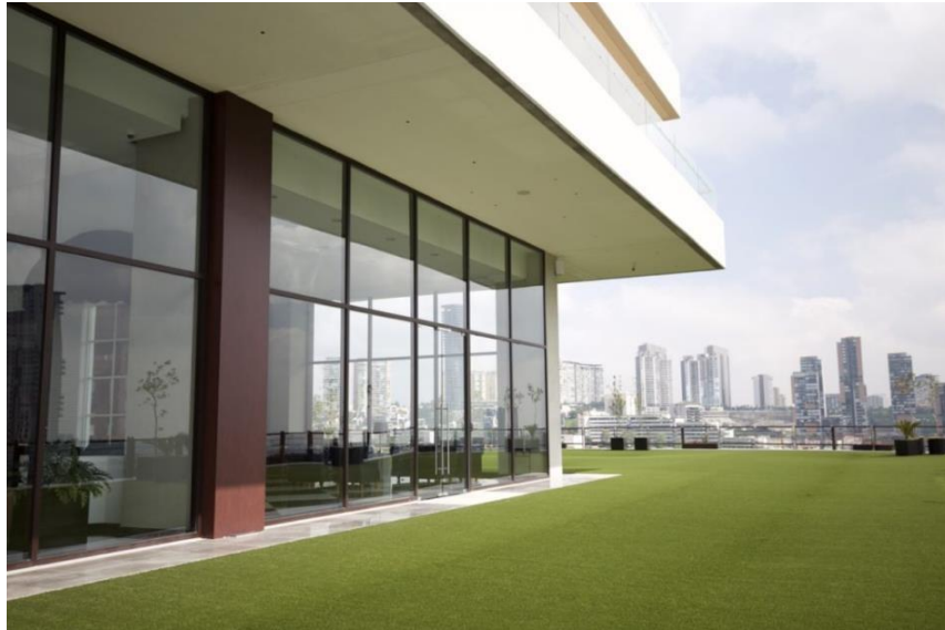
Figura 17. Ejemplo fachada en vidrio
