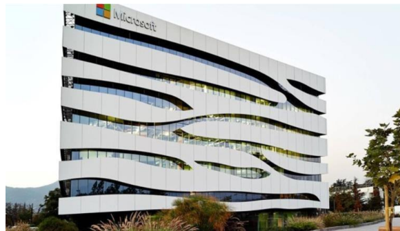
Figura 5. Fachada principal Edificio White
