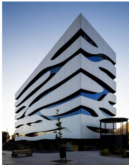
Figura 6. Vista exterior envolvente Edificio White
