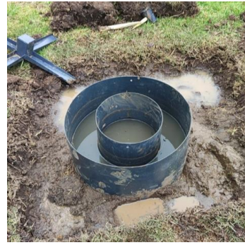
Imagen 6. Prueba de infiltración
