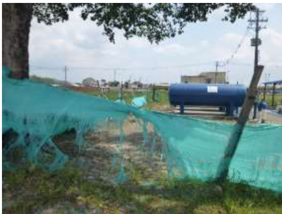
Figura 20 Encerramiento PTAP Pinares de Oriente. Fuente: María Carrillo, 2019
