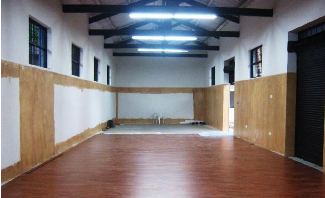
Figura 5. Local en proceso de restauración, emprendimiento Gym Sportfitness Málaga (24 de junio 2010)
