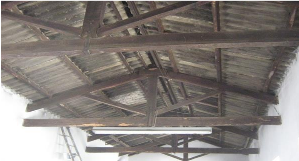
Figura 3. Local a restaurar para iniciar emprendimiento Gym Sportfitness Málaga, enero 2010.
