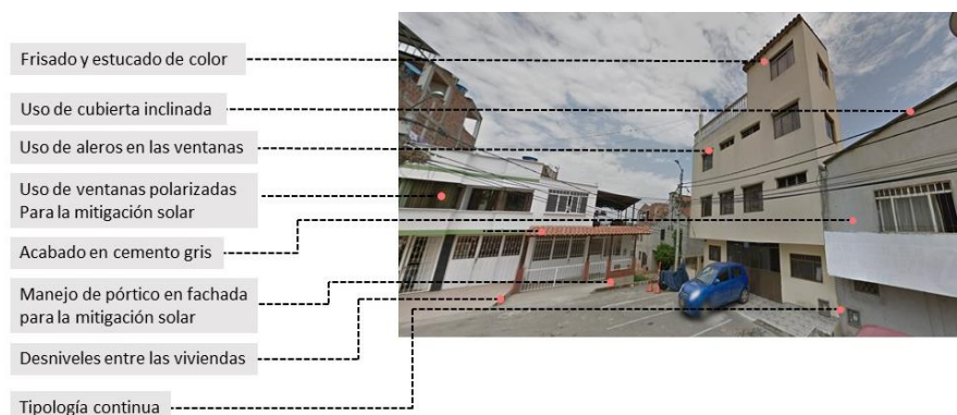
Figura 18. Viviendas aledañas al lote
