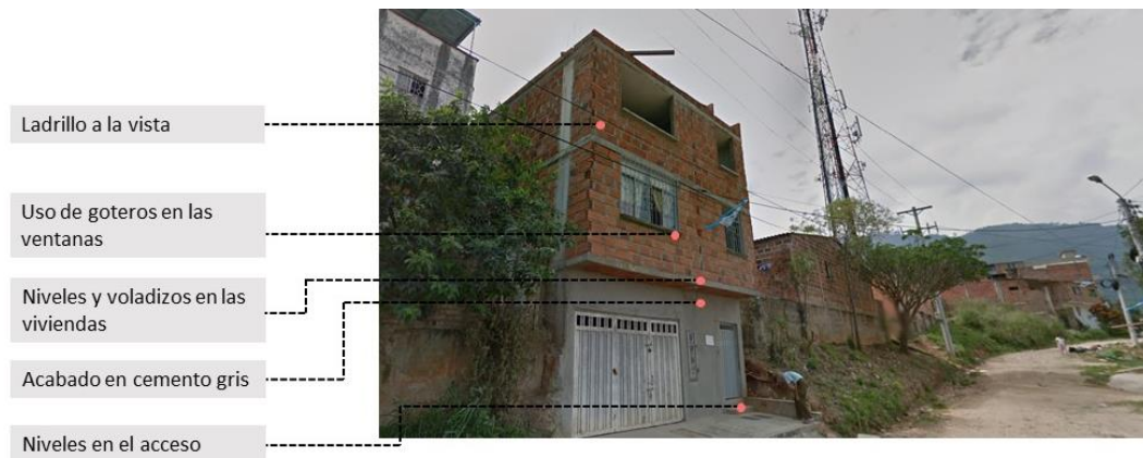
Figura 20. Viviendas aledañas al lote
