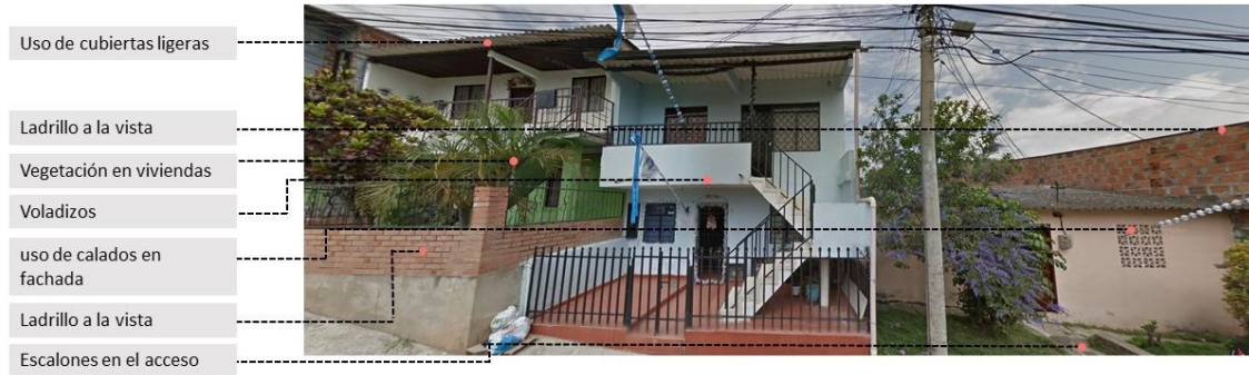
Figura 19. Viviendas aledañas al lote
