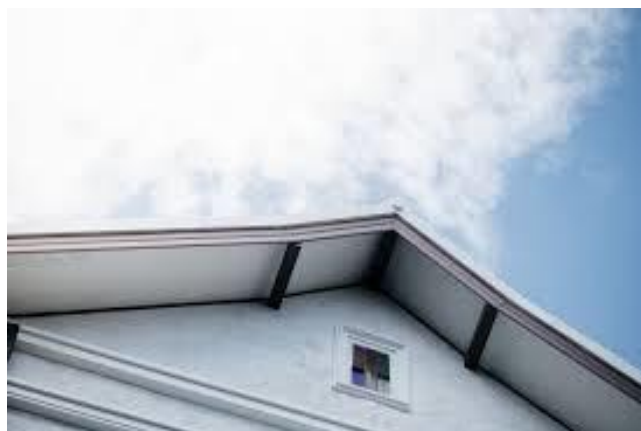
Figura 73. Aleros en las viviendas
