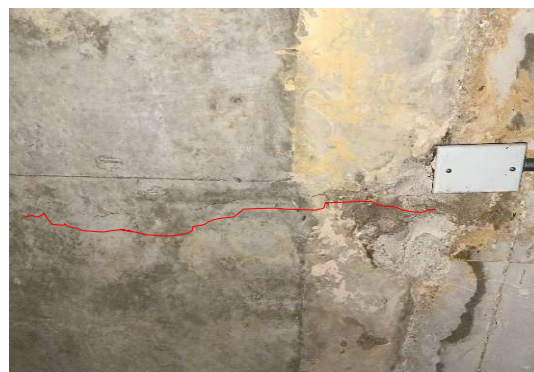
Foto 2. Placa entrepiso nivel +1,25 sótano 1
