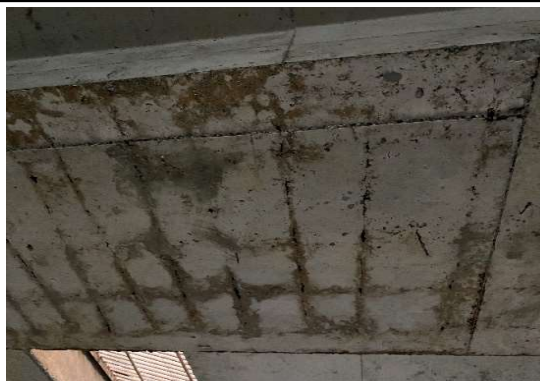
Foto 2. Viga VG-E placa nivel +1,25 sótano 1
