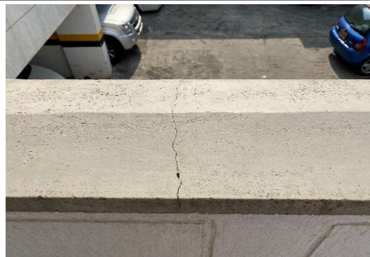
Foto 2. Alfajías en concreto parque infantil piso 2
