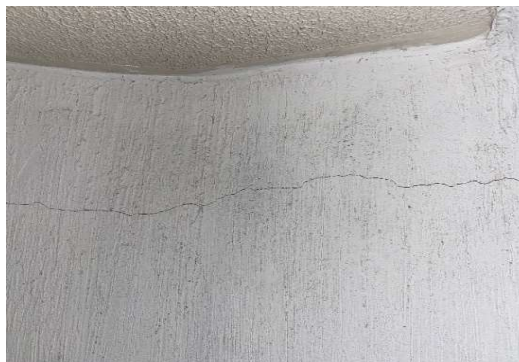
Foto 2. Muro no estructural escalera
