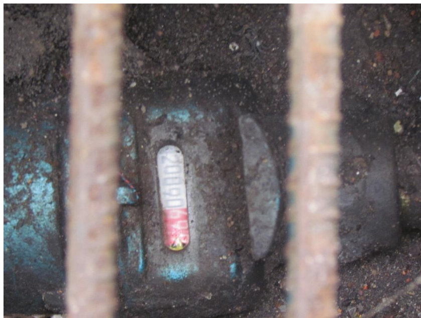
Figura 53. Contador descompuesto
