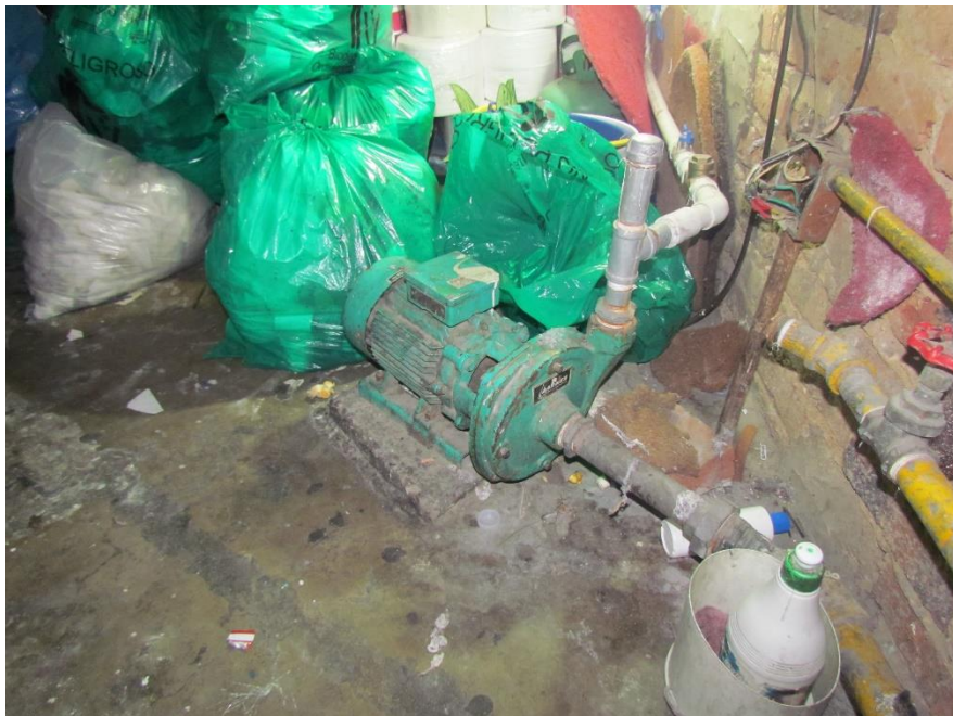
Figura 58. Sistema de tuberías
