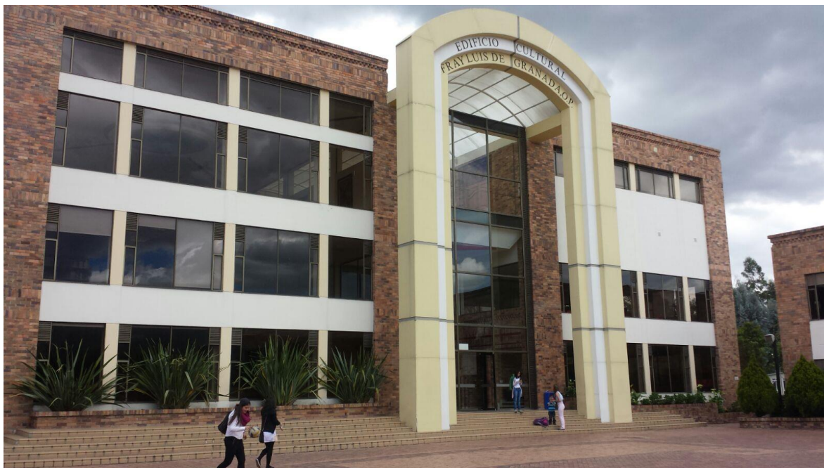
Figura 11. Edificio Cultural Campus (Tanque subterráneo)
