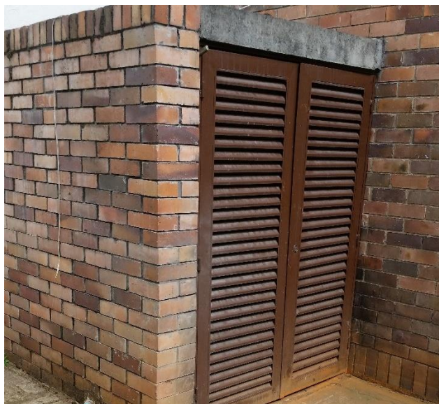
Figura 8. Cuarto de máquinas detrás del edificio cultural
