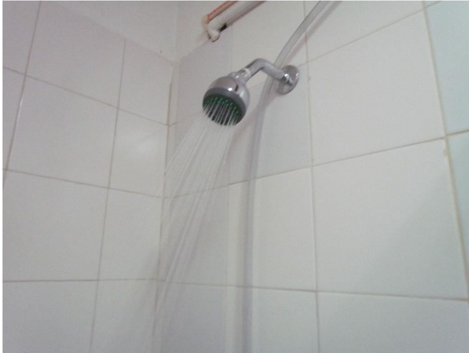
Figura 40. Ducha con dispositivo ahorrador
