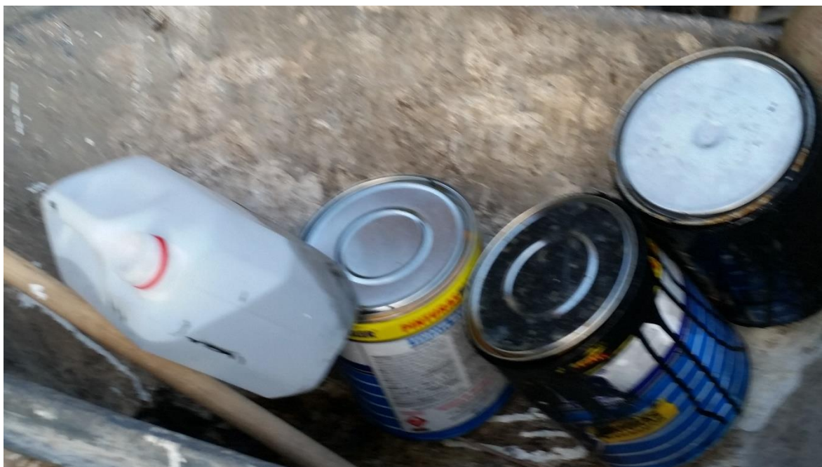
Figura 10. Thiner y pinturas en lugares inadecuados
