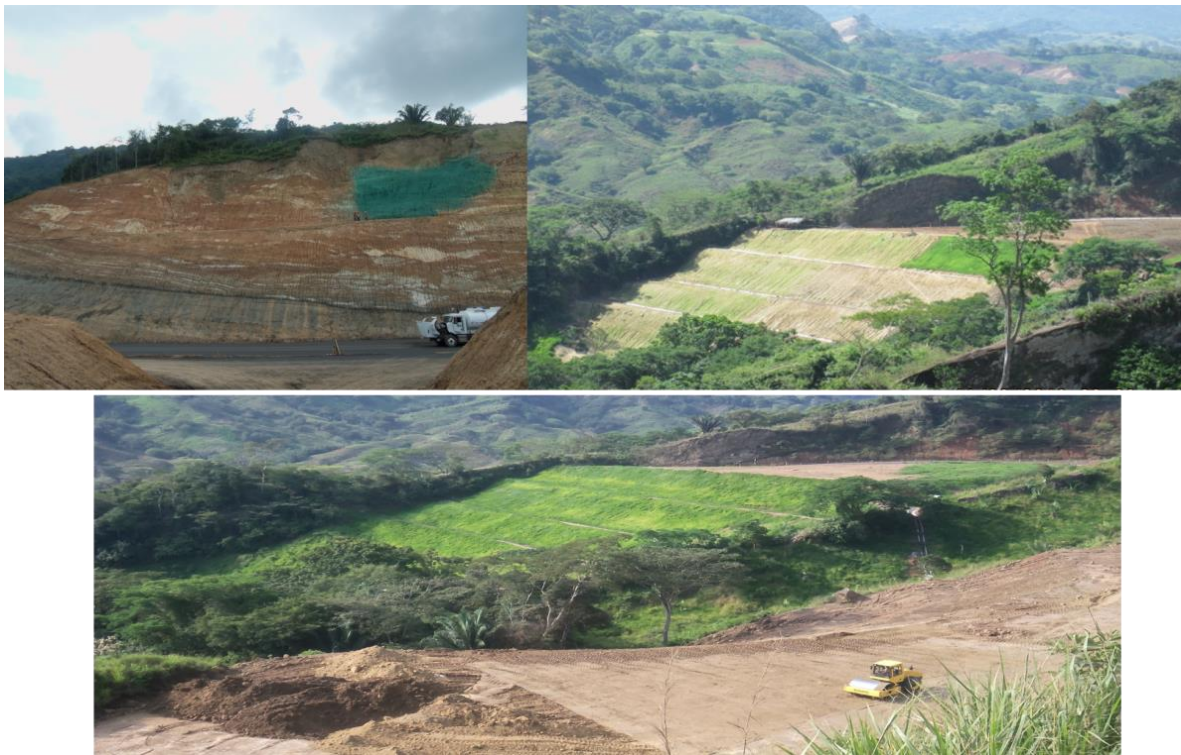
Imagen 1. Aplicación de hidrosiembra con hidromulch
