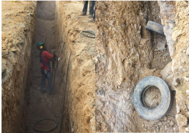
Figura 3. Detonación de piedra. Fuente autor
