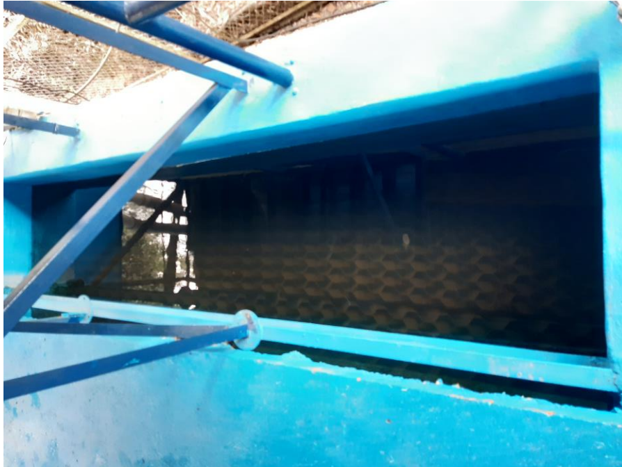
Ilustración 7. Sedimentador de flujo ascendente de alta tasa PTAP Supatá. Fuente: Propia.
