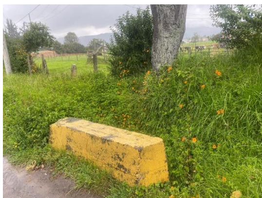
Figura 16. Demarcación de la quebrada evidenciada en la visita de inspección ocular
