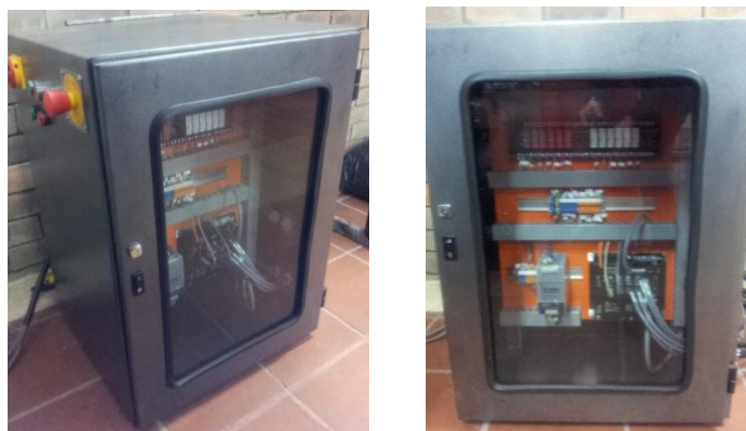
Figura 3. Controlador industrial para su implementación en el dispositivo de arquitectura paralela de 3 cadenas cinemáticas.
