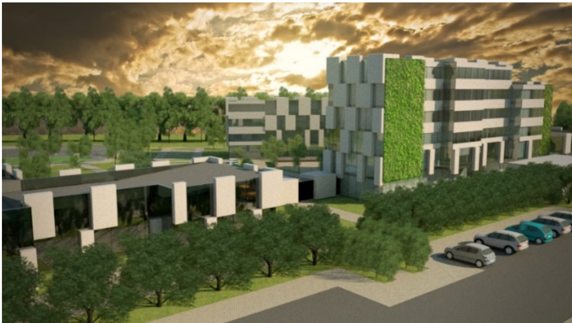
VISTA GENERAL DESDE LA VIA DE ACCESO
