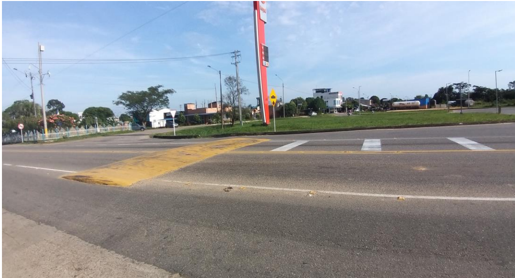
Figura 20. Medición demarcación horizontal Av. Marginal del llano.
