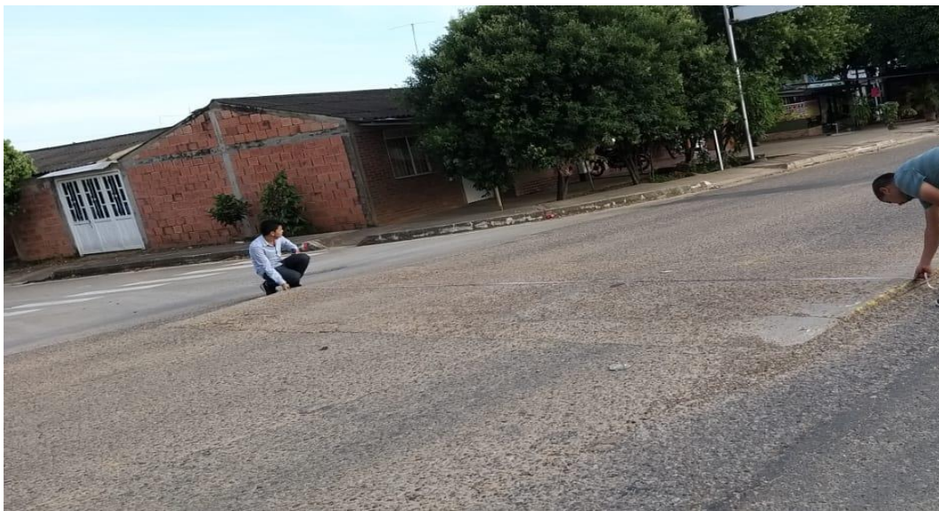
Figura 19. Medición longitudinal reductor de velocidad Calle 12.
