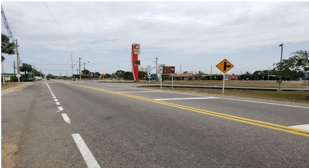
Figura 30. Señalización horizontal y vertical – Av. Marginal del llano.
