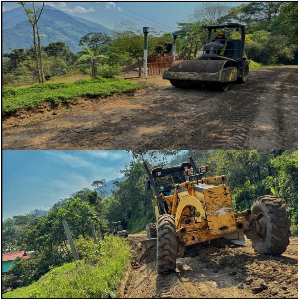
Ilustración 8. Visita técnica vía Santa María – Mámbita Dpto. Boyacá.
