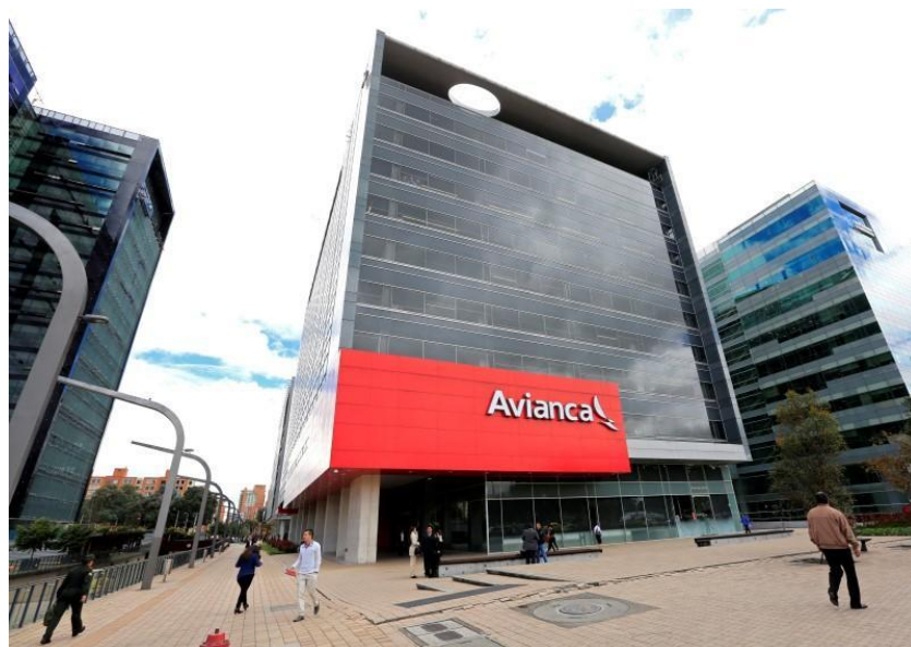
Figura 2. Fotografía Sede CAV
