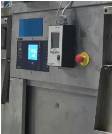
Figura 26 Instalación de programador
