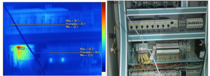
(a) Vista termográfica
