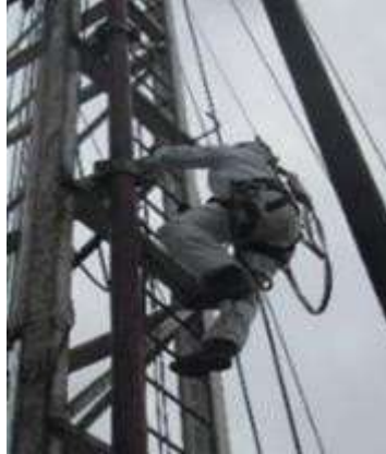
Ilustración 6 Escalera portátil - Subida a bloque de corona
