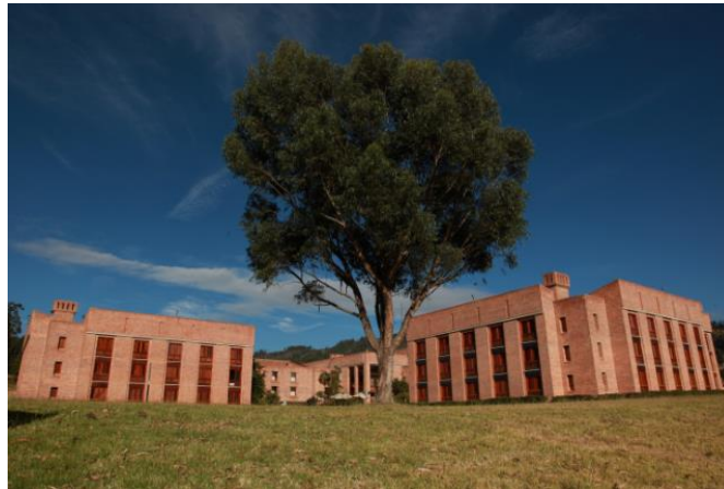
Figura 58. Centro de convenciones de Paipa - Colombia
