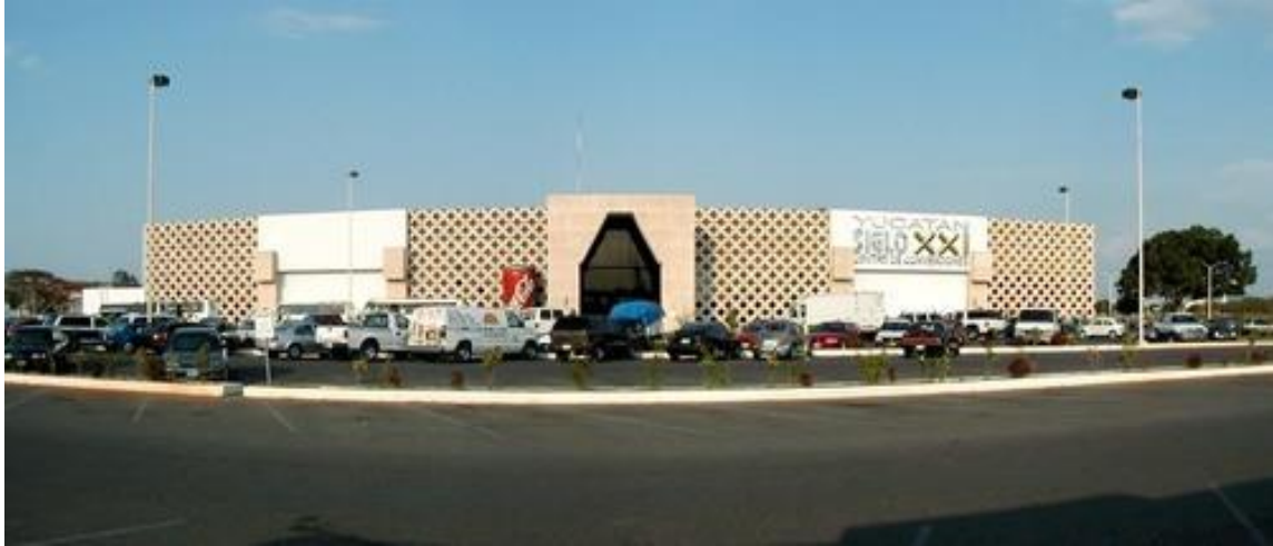
Figura 51. Centro de convenciones de Yucatán (Vista exterior) - México
