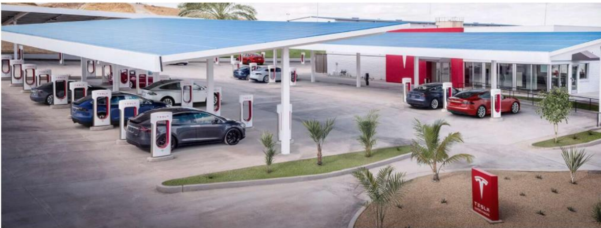
Figura 4 Estación de Carga Tesla alimentada con energía solar fotovoltaica
