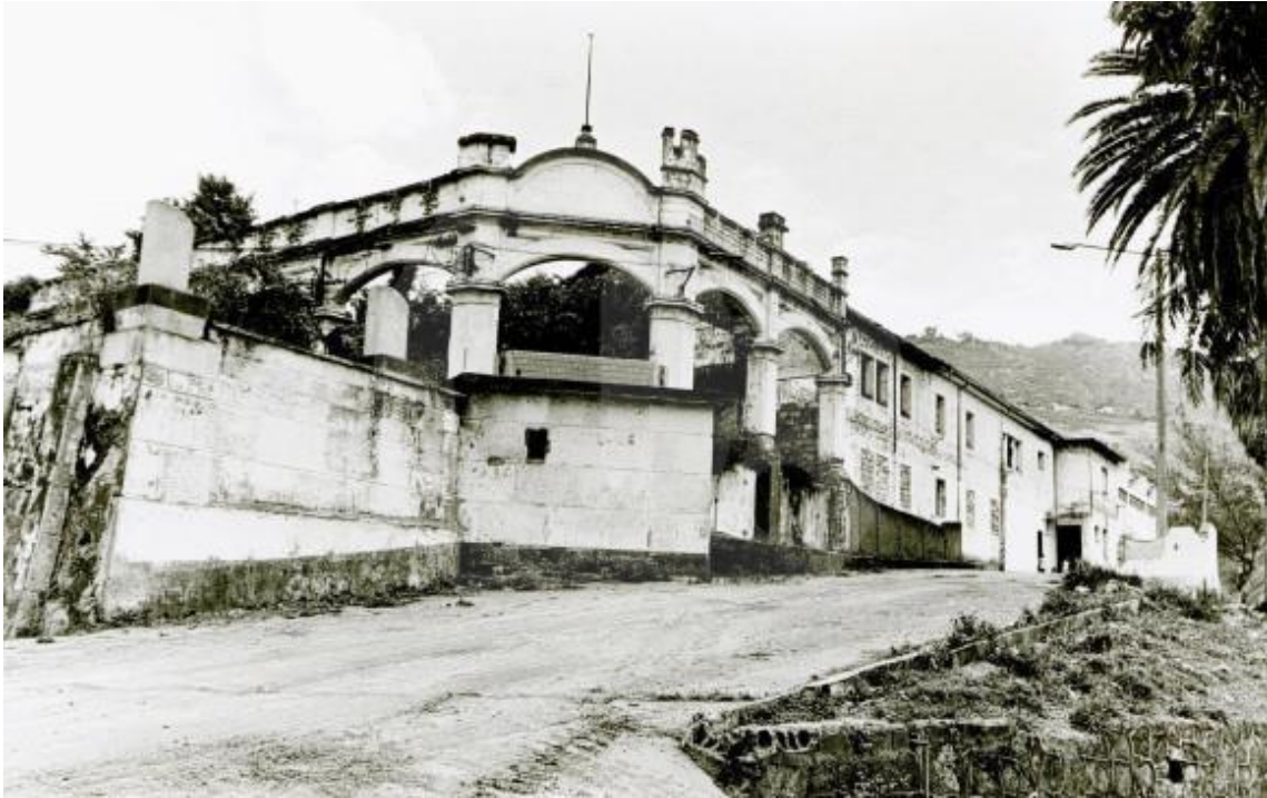
Fig. 3 Cárcel la ladera, Medellín, sector la ladera, Google
