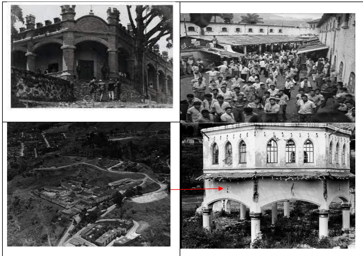
Fig. 4 Cárcel la ladera, Medellín, sector la ladera, Google
