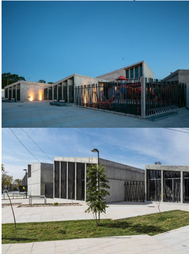
Figura 32. Vistas exteriores del centro comunitario en Celaya
