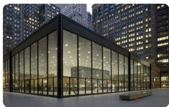
Centro Federal de Chicago, Fotografía tomada de artnet news.
