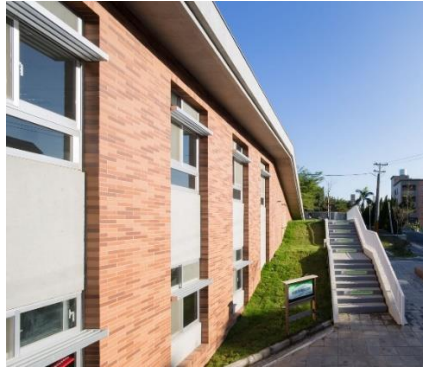
Figura 8. Estación de Bomberos de Vitra
