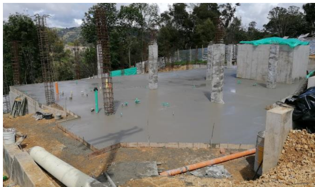
Ilustración 22 placa de contrapiso Fuente: Autor
