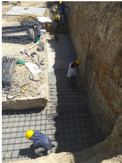
Ilustración 7 solado de limpieza
