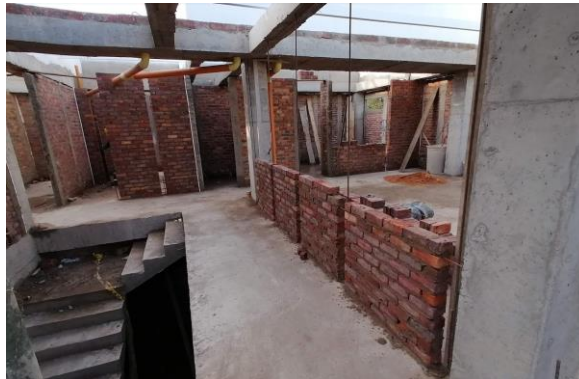
Ilustración 23 muros internos
