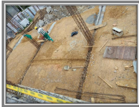
Ilustración 5 vigas de cimentación nivel -3.00\text{ m}
