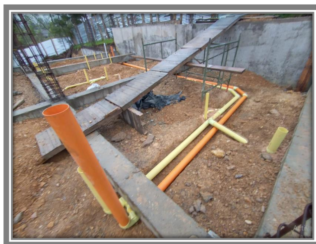
Ilustración 6 excavación redes hidráulicas
