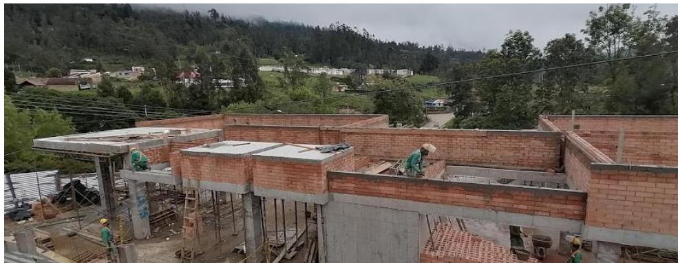
Ilustración 18 placas de cubierta nivel +4.00
