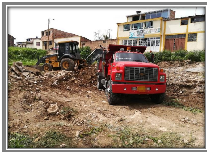
Ilustración 2 descapote lote Fuente: Autor
