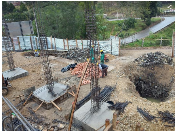
Ilustración 9 zapatas nivel -3.00 m
