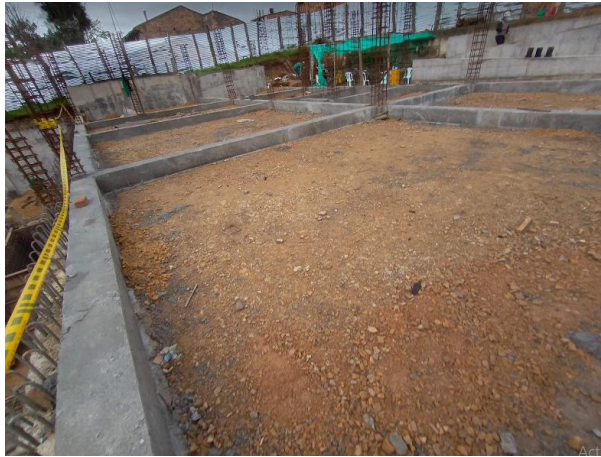
Ilustración 10 vigas nivel +0.00 m
