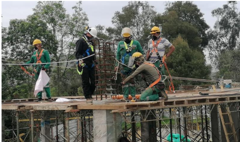
Ilustración 24 Trabajadores con implementos de seguridad
