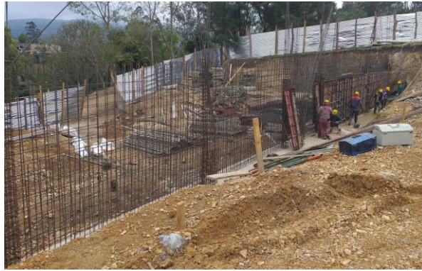
Ilustración 13 acero muros
