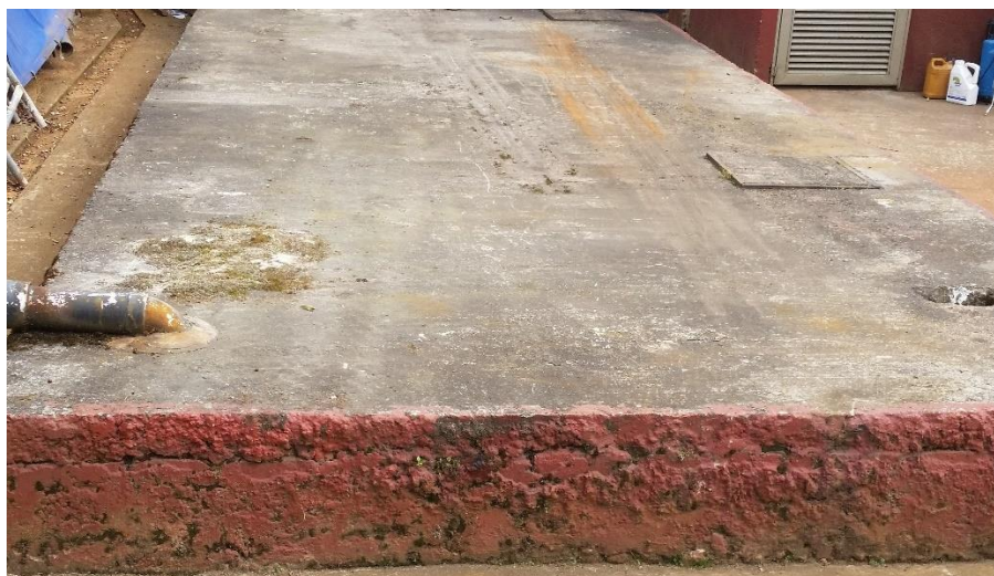
Figura 16. Tanque de almacenamiento subterráneo
