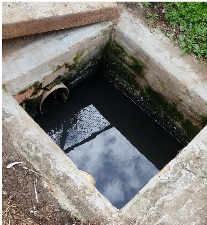
Figura 8. Tanque de aguas negras
