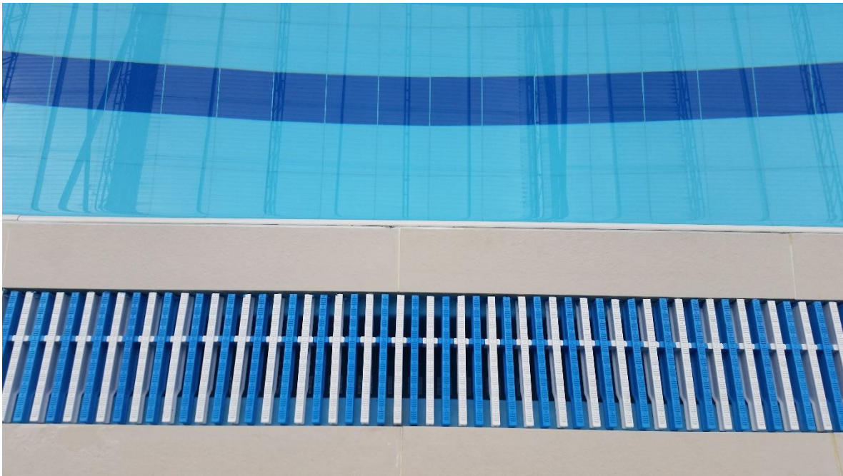
Figura 21. Recirculación de agua para tratamiento
