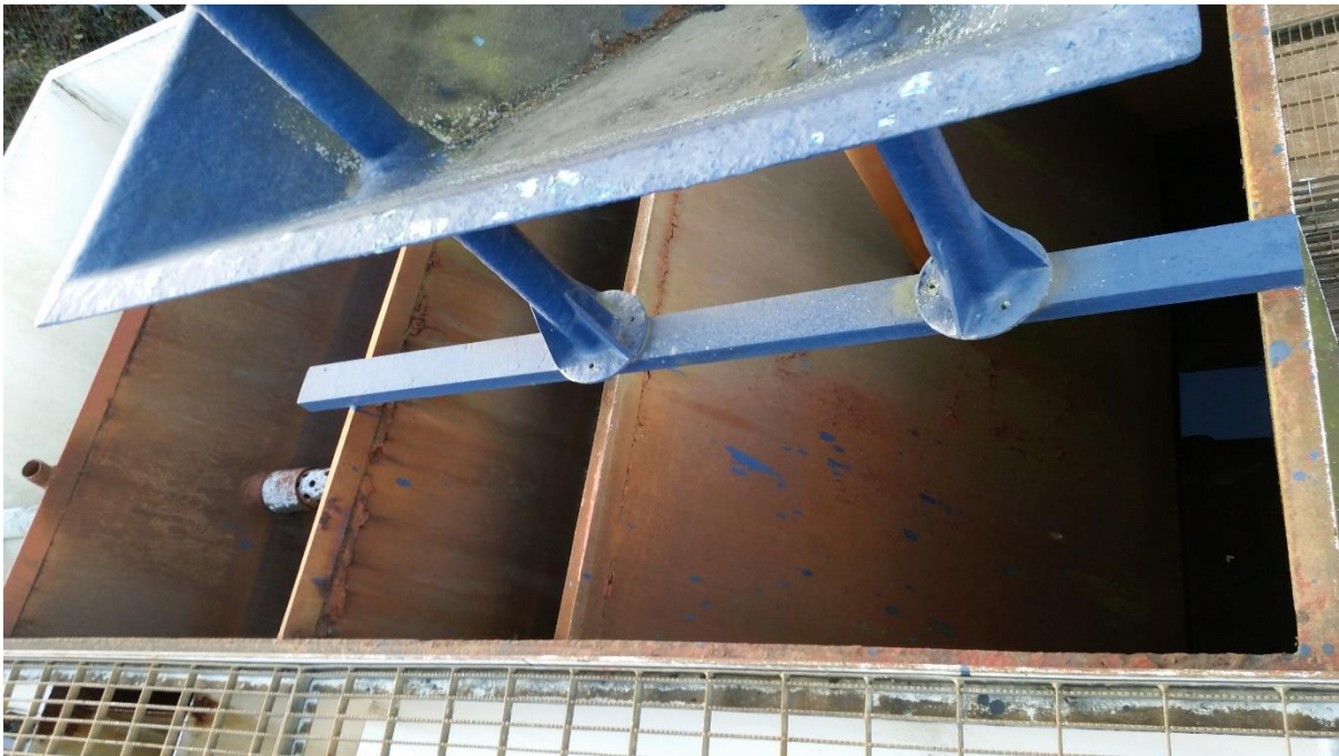
Figura 17. Sistemas de bandejas en PTAP clausurada
