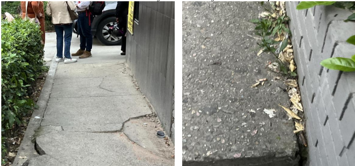
Figura 28. Resultado de evaluación del estado físico de la infraestructura peatonal.
