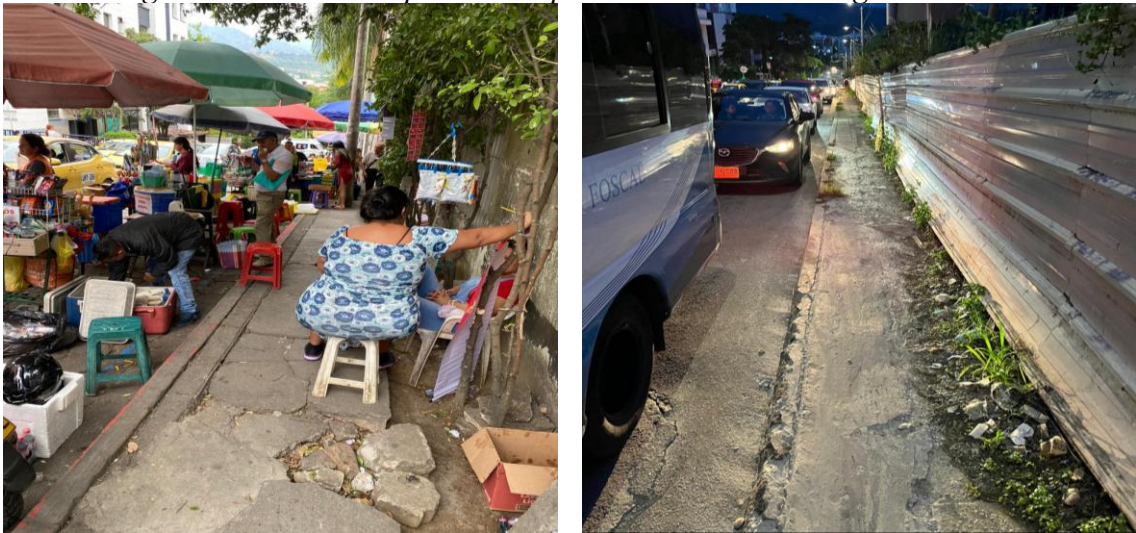
Figura 11. Estado general de las rutas peatonales para su evaluación integral
