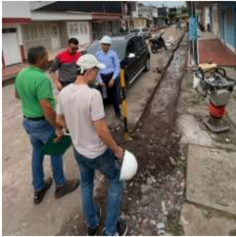
Figura 21 Reposición de pavimento flexible
