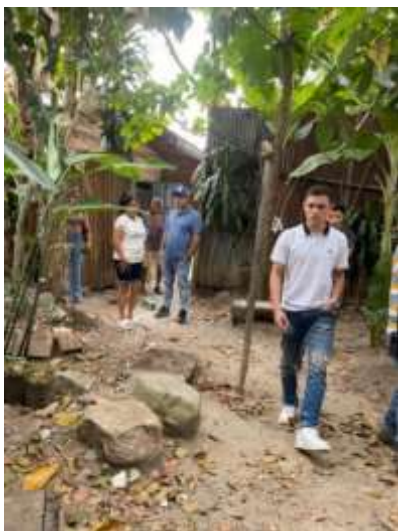
Revisión del mal estado del sistema de alcantarillado por falta de mantenimiento
