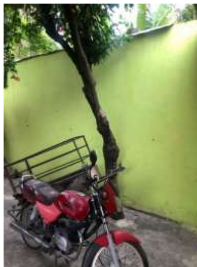
Muro que impedía el paso a los funcionarios de la EAAV
