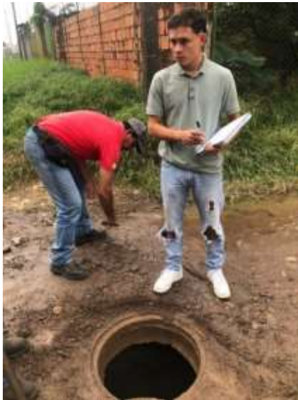
Inspección del problema con la colisión de la tubería de alcantarillado.
