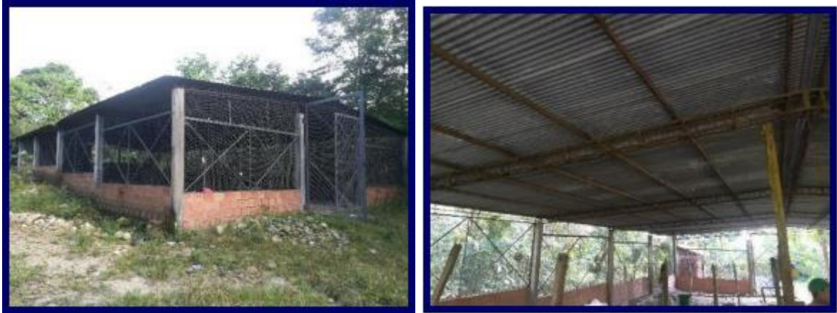
Imagen 12 Infraestructura de almacenamiento residuos inorgánicos aprovechables
