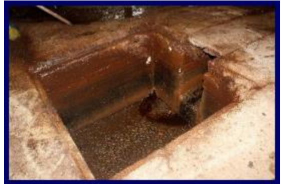
Imagen14 Camas de compost y tanque de recolección de lixiviados
