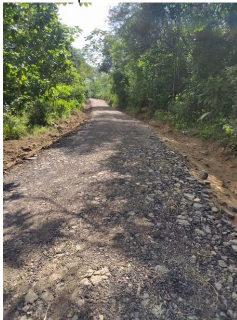
Figura 17. Compactación del material.
