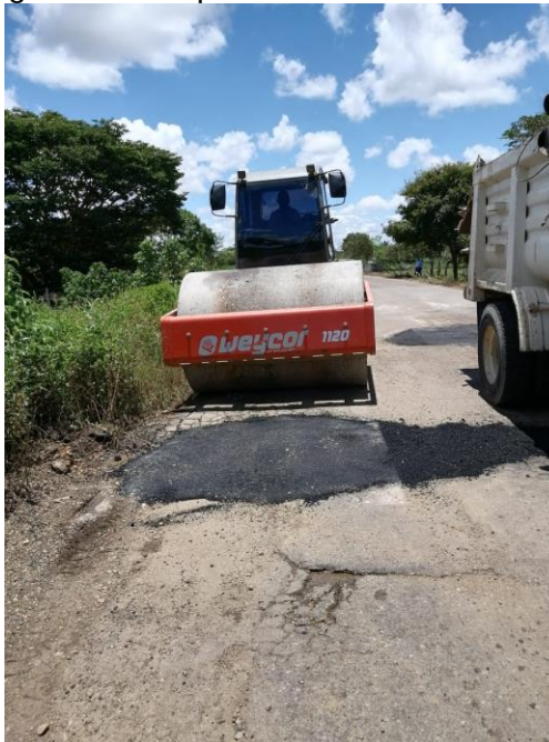
Figura 3. Compactación mezcla asfáltica.
