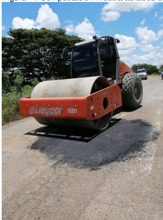
Figura 4. Compactación mezcla asfáltica 2.
