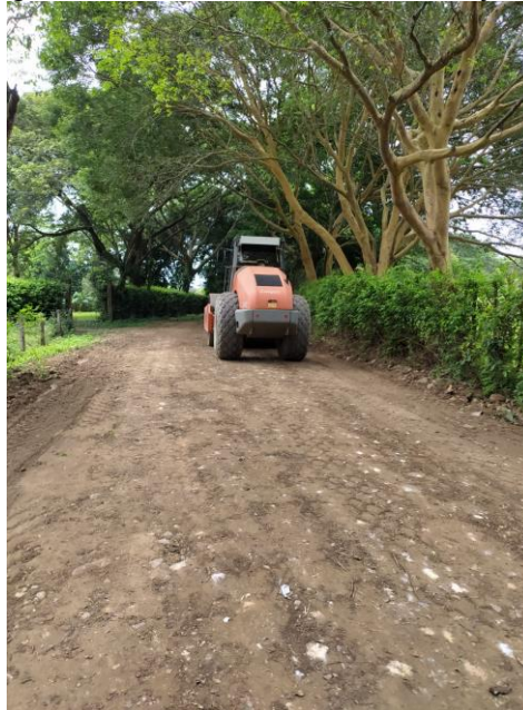
Figura 8. Mantenimiento vía Merey.
