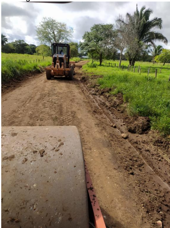
Figura 6. Nivelación del suelo.
