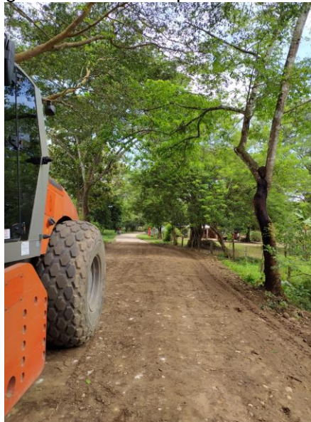
Figura 9. Unión vía pavimentada.
