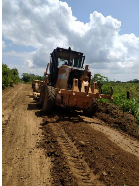
Figura 14. Raspado de la carretera.
