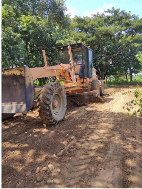
Figura 12. Nivelación de la vía.
