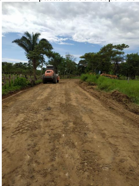
Figura 11. Compactación de la superficie.
