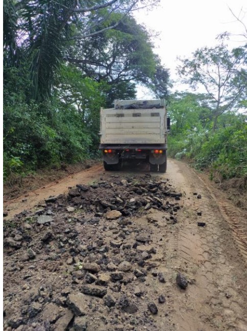
Figura 16. Riego del material.
