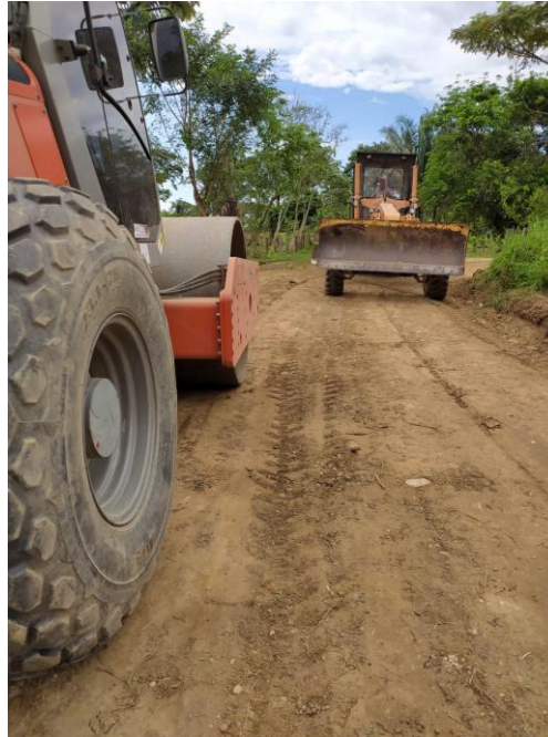
Figura 10. Mantenimiento vía la Selva.
