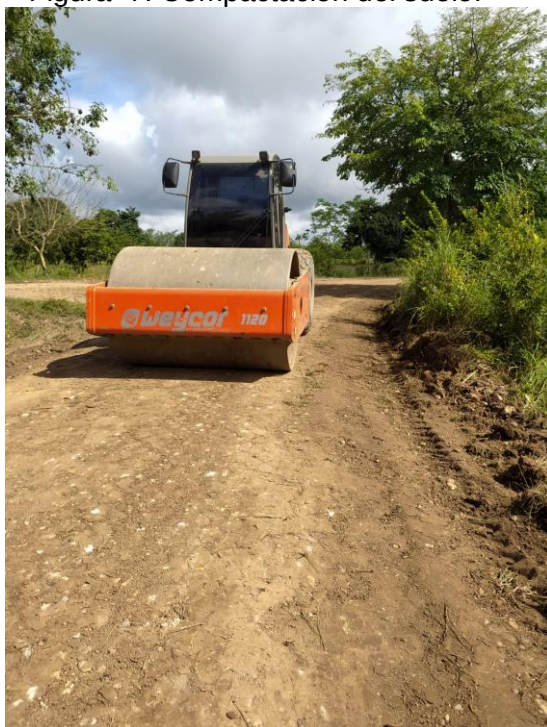
Figura 7. Compactación del suelo.
