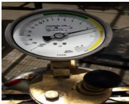
Ensayo De Contenido De Aire Del Concreto
