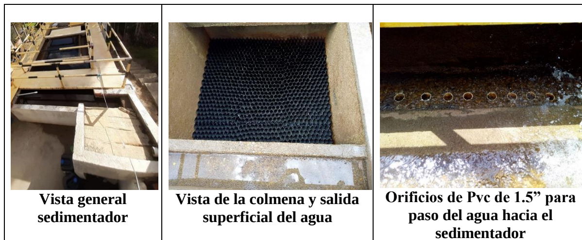
Imagen 12. Sedimentador de colmena de alta tasa.
