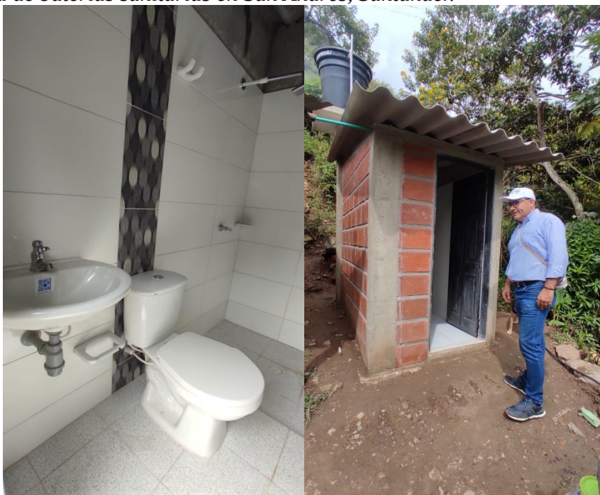
Figura 13. Entrega de baterías sanitarias en San Andrés, Santander.
