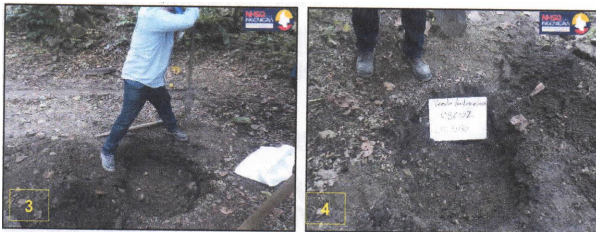
Fotografía 6. Toma de Muestra para CBR No 2. Vereda La Argentina
