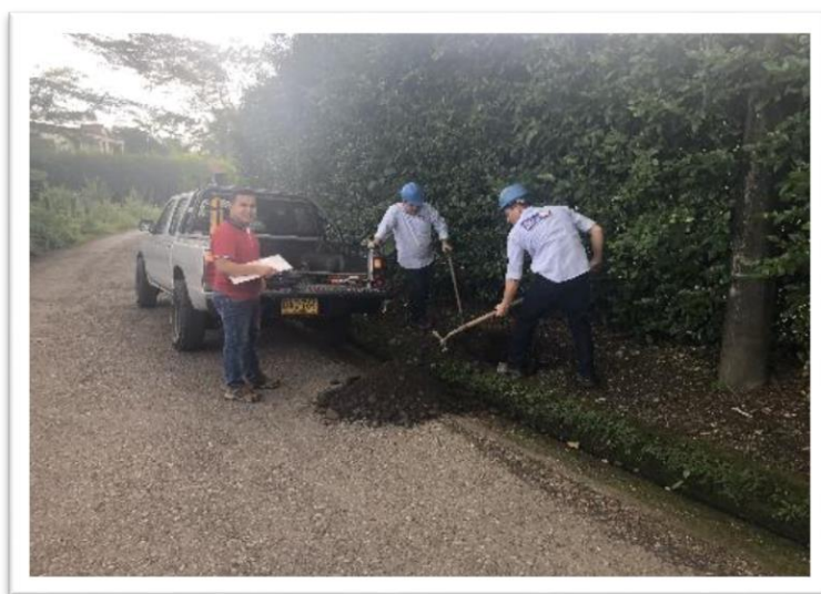
Fotografía 8. Realización del primer apique. Vereda La Argentina.
