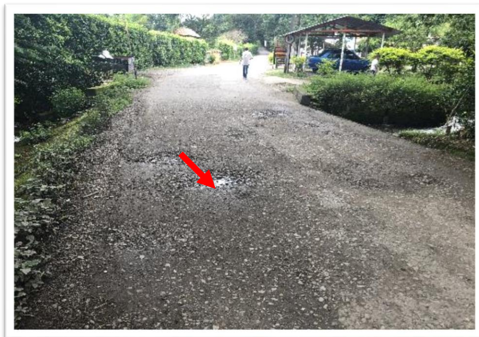
Fotografía 11. Localizadas en el Tramo C. Vereda La Argentina
