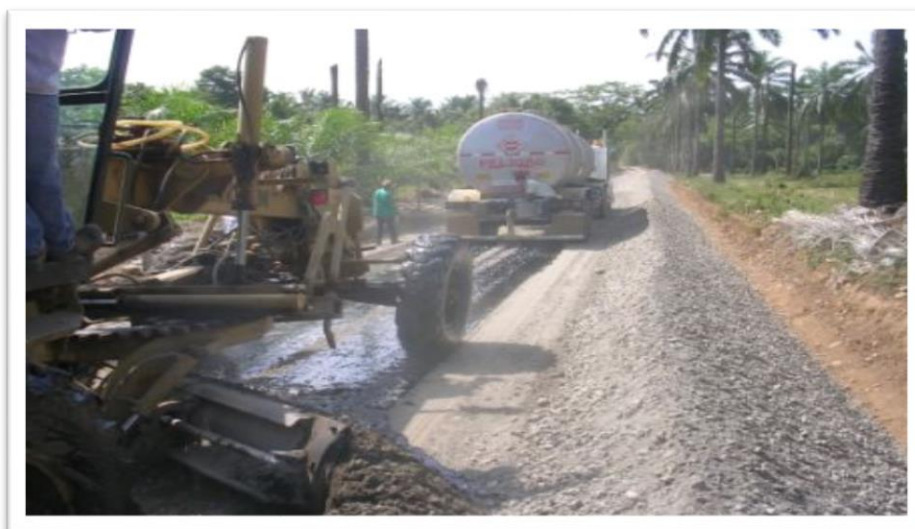
Fotografía 3. Carrotanque imprimador aplicando escalonadamente el crudo de Castilla. Vereda María Piñuela
