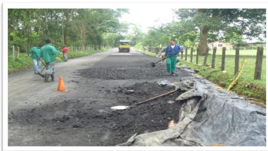
Fotografía 4. Extensión de crudo de Castilla con Pala y Regla a mano. Vereda María Piñuela.
