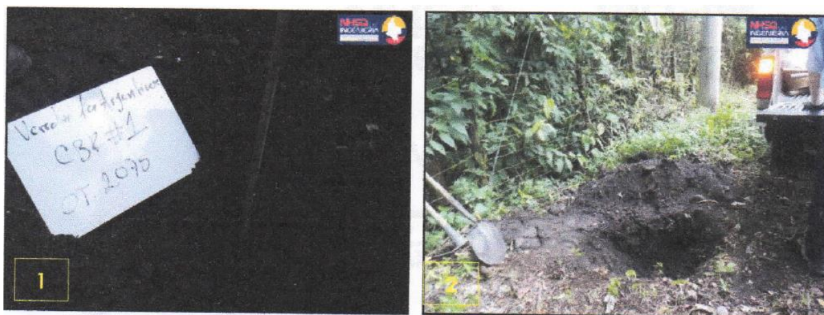
Fotografía 5. Toma de Muestra para CBR No 1. Vereda La Argentina
