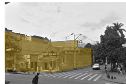
Fotografía 1 Hospital San Vicente de Paúl
