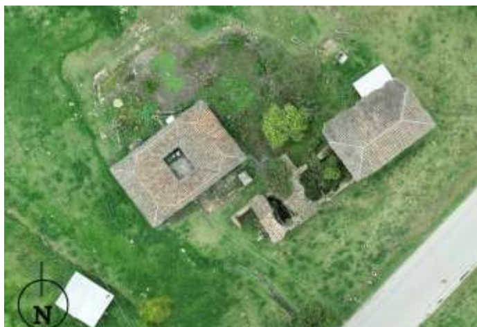
Fotografía 29- Estado de cubiertas hacienda Aposentos. Fuente: TORRES, Dolly (Nov. 2020)
