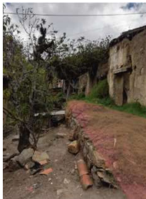
Fotografía 17- Circulación primera planta hacienda Aposentos. Fuente: Dolly Torres (Sep.2020)
