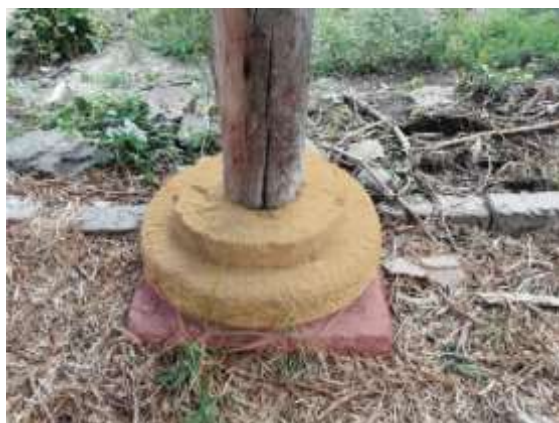
Fotografía 19- Basamento y soporte de piedra. hacienda Aposentos. Fuente: Dolly Torres (septiembre 2020)
