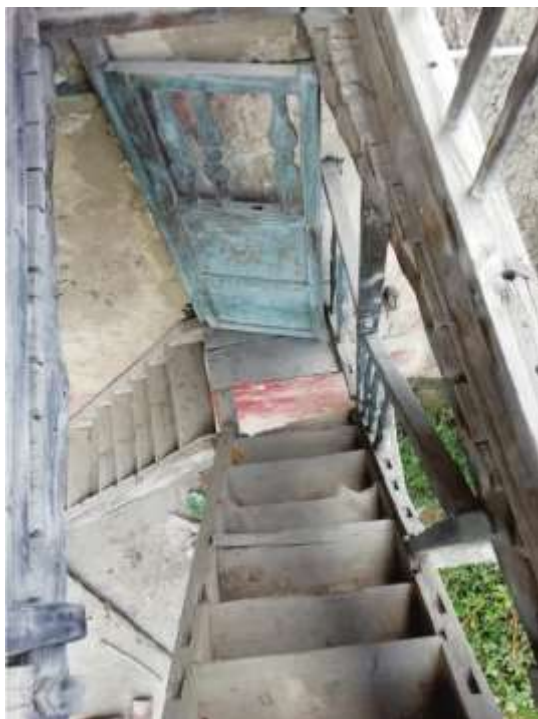
Fotografía 22- Escaleras hacienda Aposentos. Fuente: Dolly Torres (septiembre 2020)
