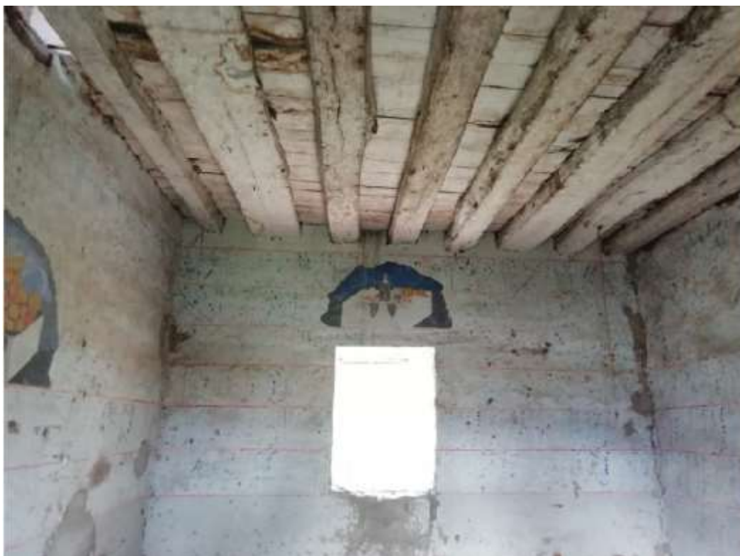
Fotografía 28- Entrepiso hacienda Aposentos de Santa Barbara. Fuente: TORRES, Dolly (Sep. 2020)
