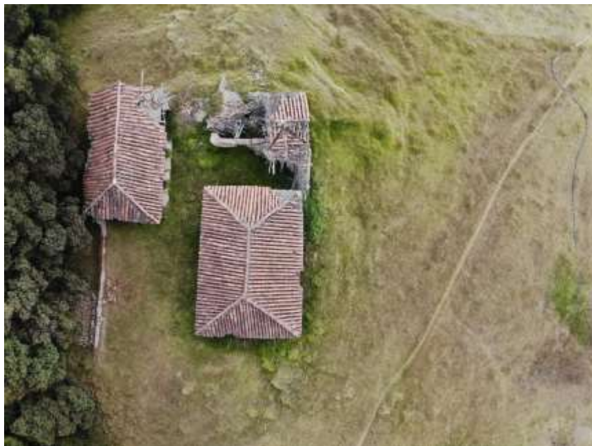
Fotografía 5-Cubierta a 4 aguas. Hacienda La Villa. Toca, Boyacá. Fuente: ROJAS, Francisco (Jun.2019)
