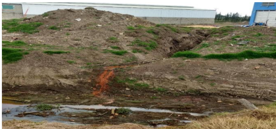
Imagen 11: vertimientos de agua residual de obras
