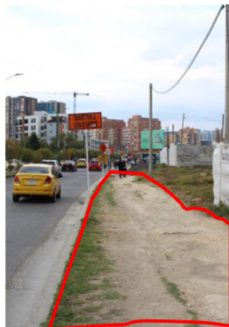
Imagen 9. Análisis fotográfico Andenes en desarrollo debido a las construcciones que se están llevando a cabo en el sector
