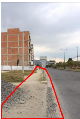
Imagen 8. Análisis fotográfico Andenes en desarrollo debido a las construcciones que se están llevando a cabo en el sector
