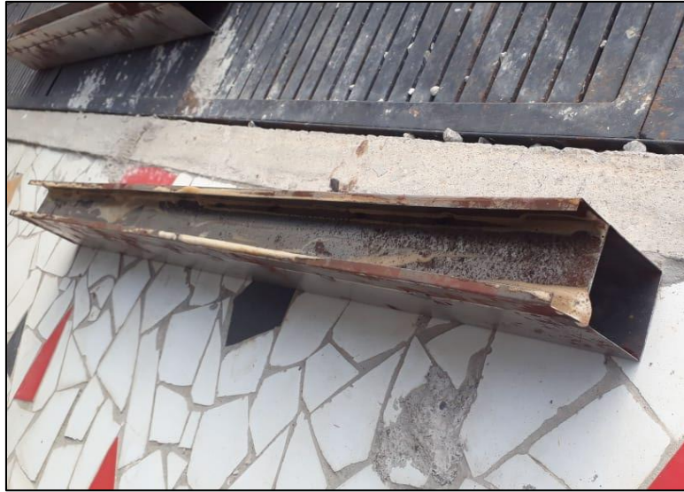
Foto 3. Lavado del perlin superior. Fuente. Autor.
