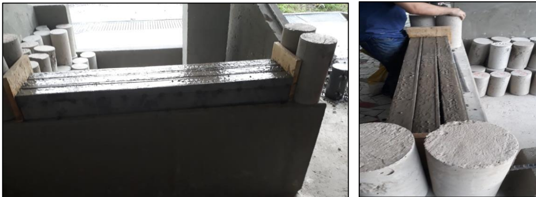
Foto 4. Rellenado del perlin superior. Fuente. Autor.
