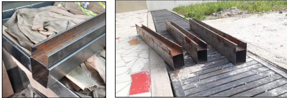
Fotos 1 y 2. Armado de los perlines de acero. Fuente. Autor.
