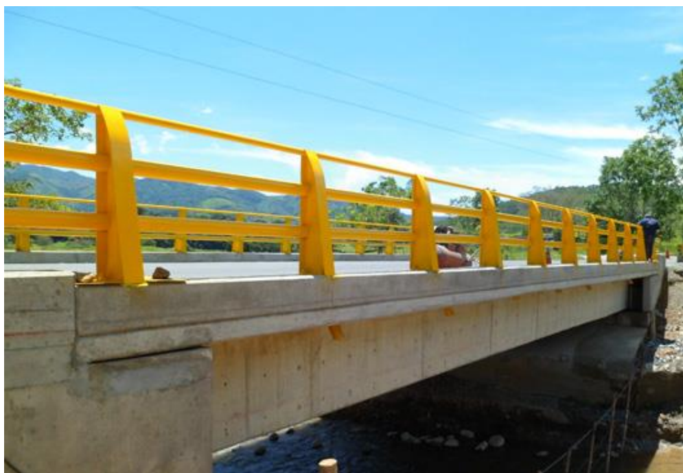
Puente en concreto reforzado
