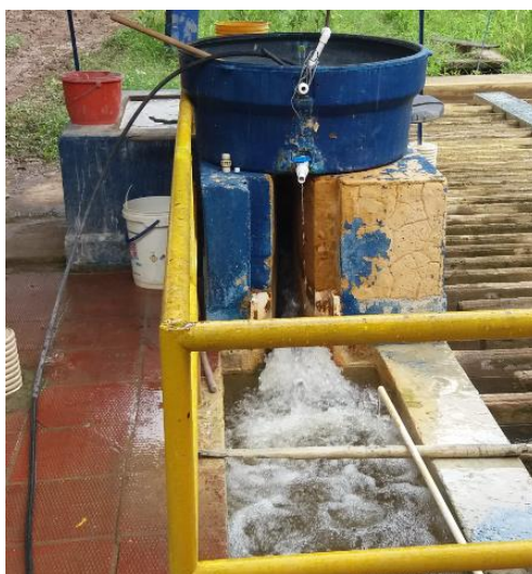
Ilustración 7. Aforador parshall. Fuente: propia
