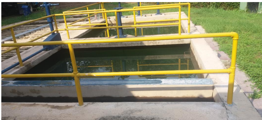
Ilustración 11. Sedimentador. Fuente: propia
