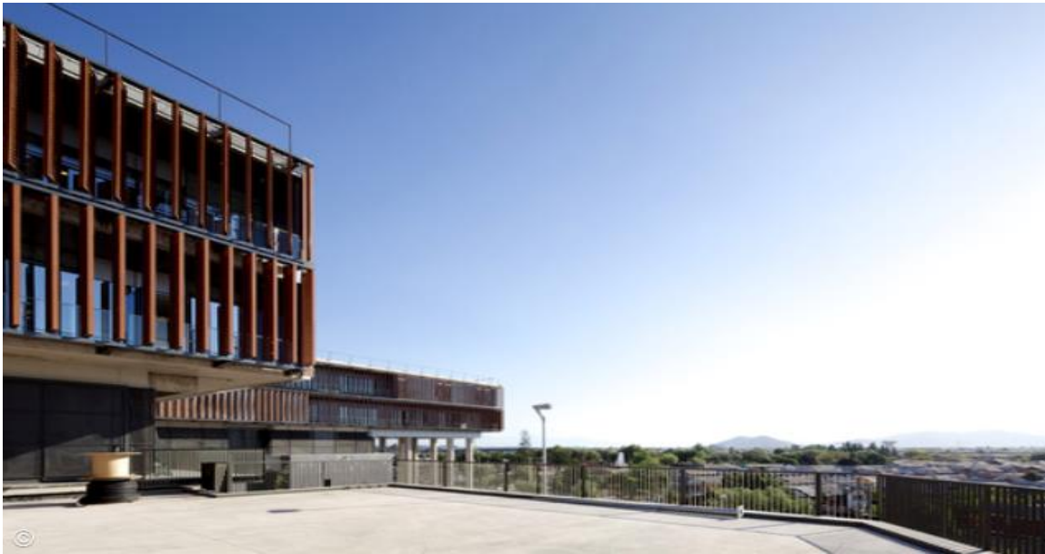
Figura 1. Fachada flotante con detalle de protección solar.
