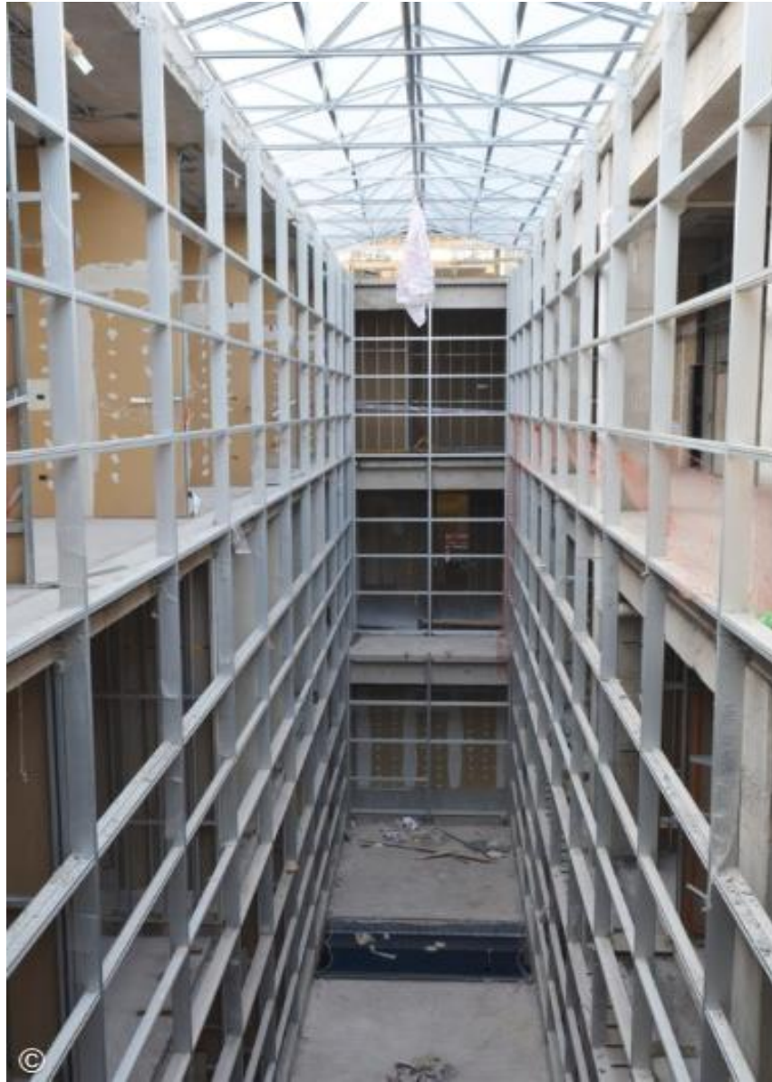
Figura 4. Vista interior hospital Carmen de Maipú.
